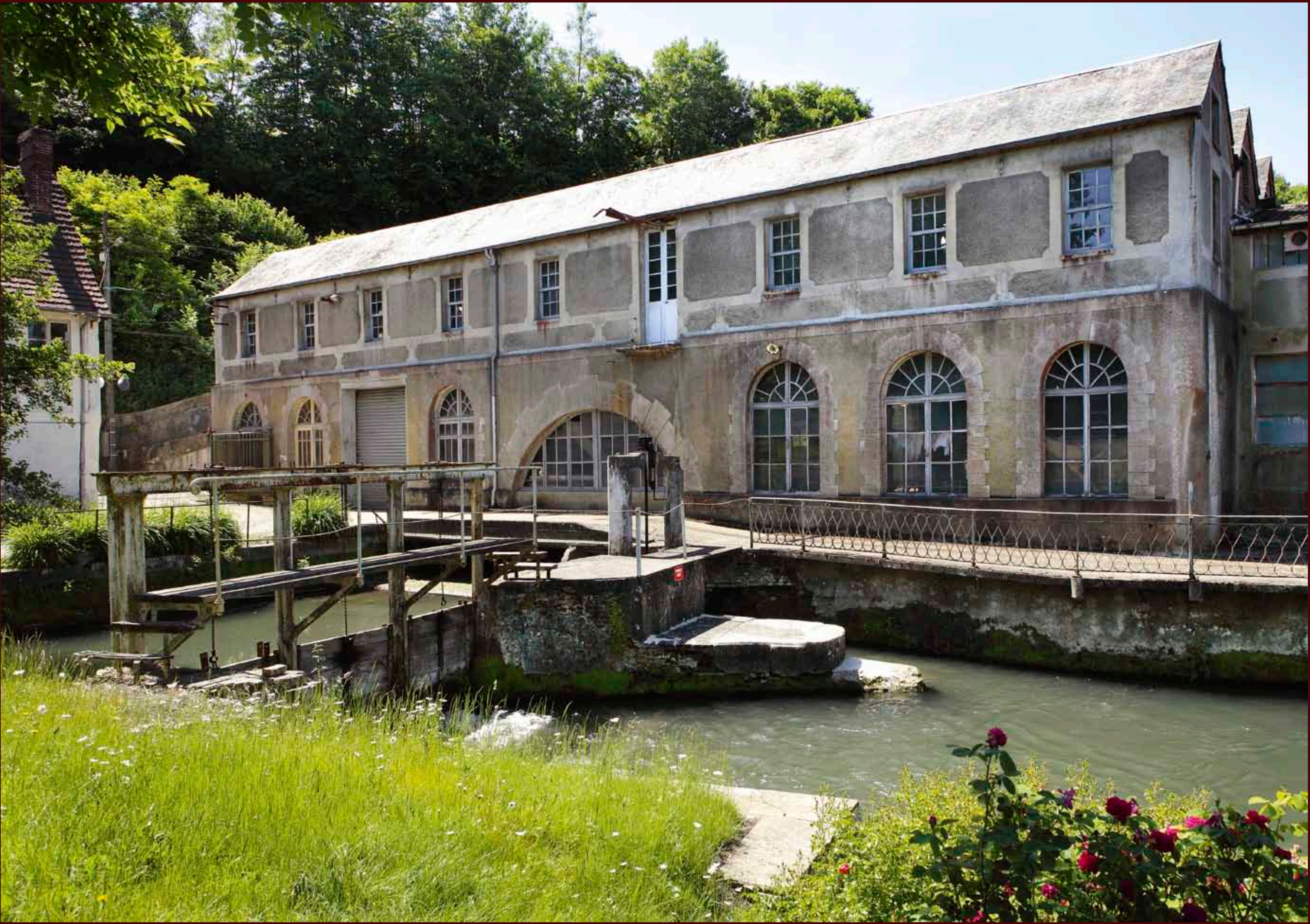
Vue générale de l'usine. A gauche, l'ancienne filature hydraulique, à droite les ateliers édifiés en 1926. Ces derniers consistent en de vastes halles de plein-pied construites en béton. Pour sa production de selles, l'usine Tron et Berthet utilisait du cuir tanné et de l'acier fon forgé et en fil. Ces matériaux, produits localement, étaient transformés à l'aide de presses à découper, à emboutir et autres machines spéciales.
