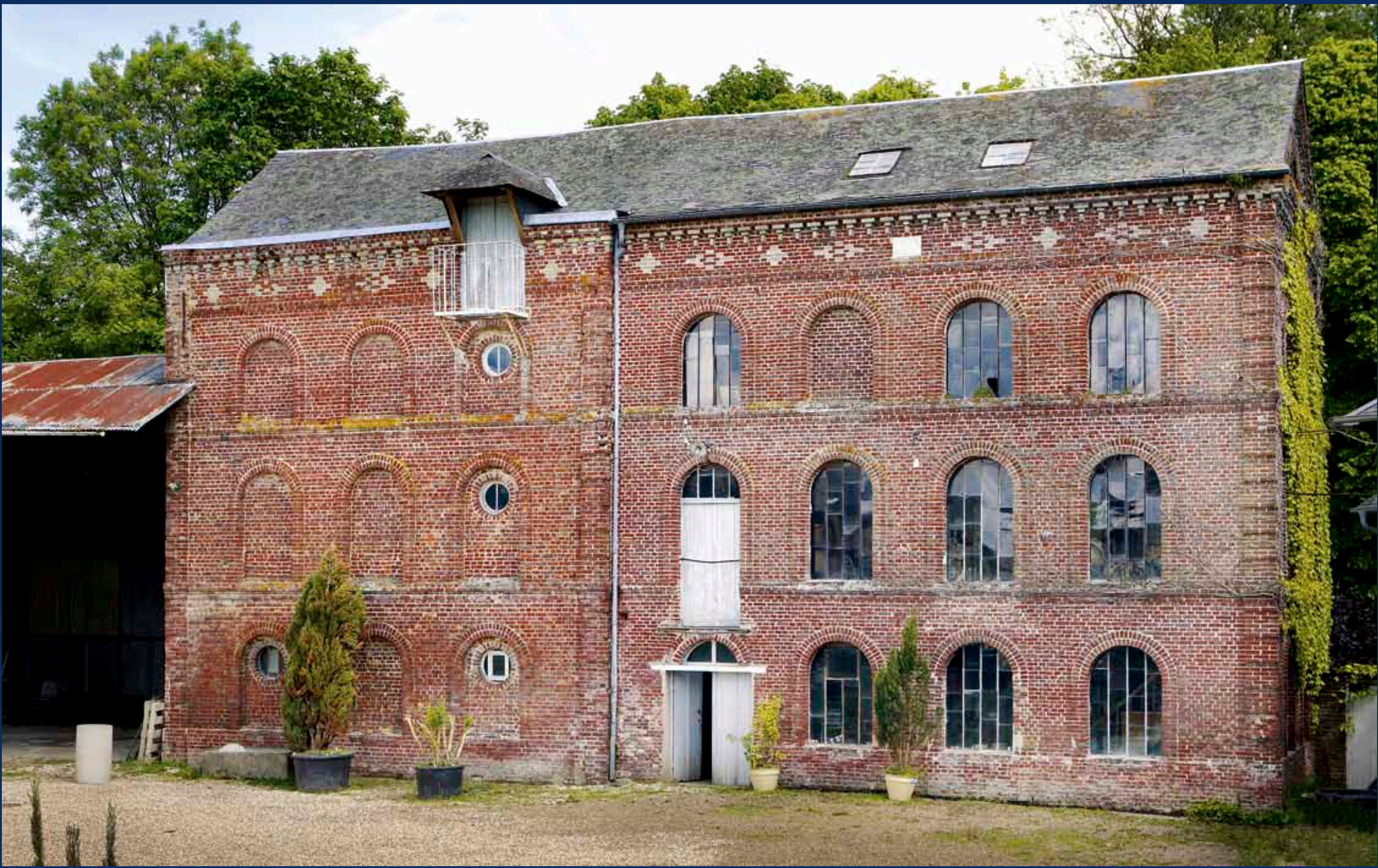
Fleury-sur-Andelle. Minoterie Lainé, 1862. Construite à l'emplacement d'un moulin à blé incendié, cette minoterie a fonctionné jusque dans les années 1970 avec sa roue hydraulique de poitrine - également appelée roue de côté car l'eau pénètre par le côté dans ses aubes.
