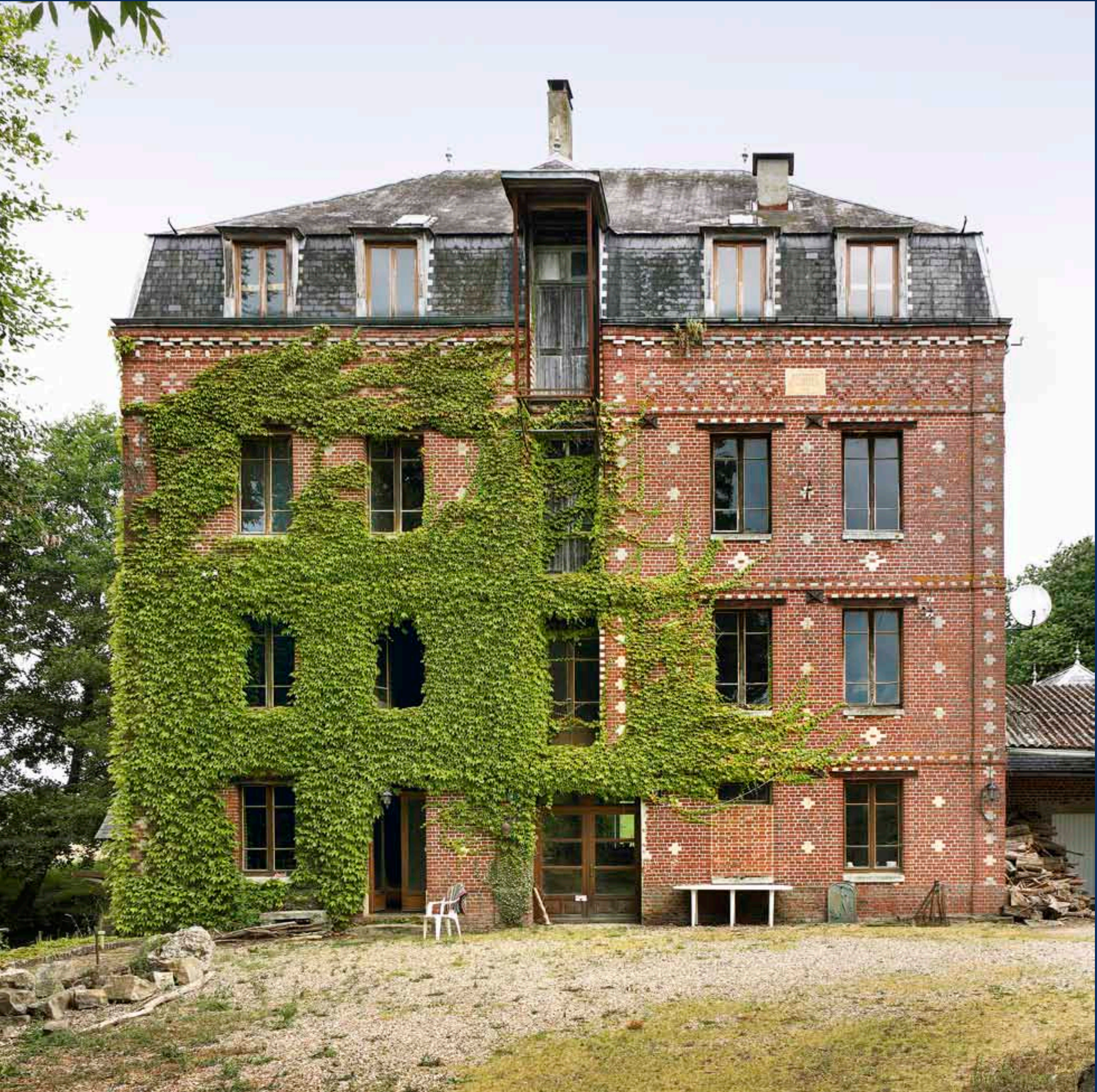
Saint-Aignan-sur-Ry. Minoterie de Saint-Arnoult, 1864. Dans le courant des années 1850, le moulin de Saint-Arnoult est équipé de broyeurs à cylindres et transformé en minoterie. Pour entraîner ces machines, une nouvelle roue hydraulique est installée. Elle mesure 5 m de diamètre sur 1,40 m de largeur. La minoterie de Saint-Arnoult a fermé dans les années 1970, elle avait une capacité d'écrasement de 40 quintaux de blé par jour. On distingue au centre de la façade, le « balcon farinier » qui servait de monte-charge jusqu'au grenier. Toutes les minoteries de la fin du XIX e siècle en sont pourvues.
