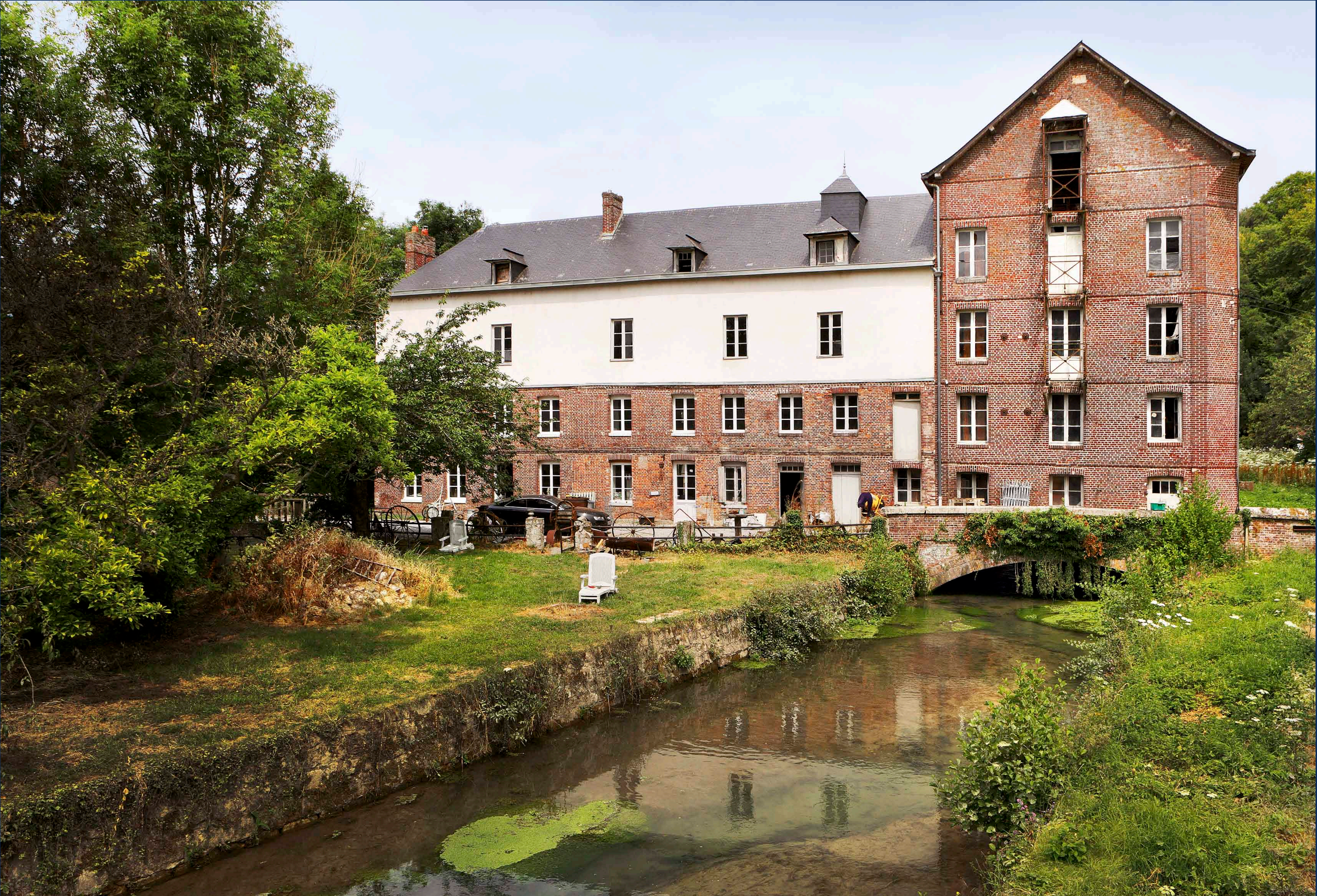
Blainville-Crevon. Minoterie Grivet, 1901. Cette imposante minoterie est construite sur cinq niveaux pour permettre un processus de production vertical. Elle avait, au début du XX e siècle, une capacité d'écrasement de 75 quintaux de blé par jour. Le corps de bâtiment construit dans son prolongement sert à la fois d'habitation au meunier et de lieu de stockage.
