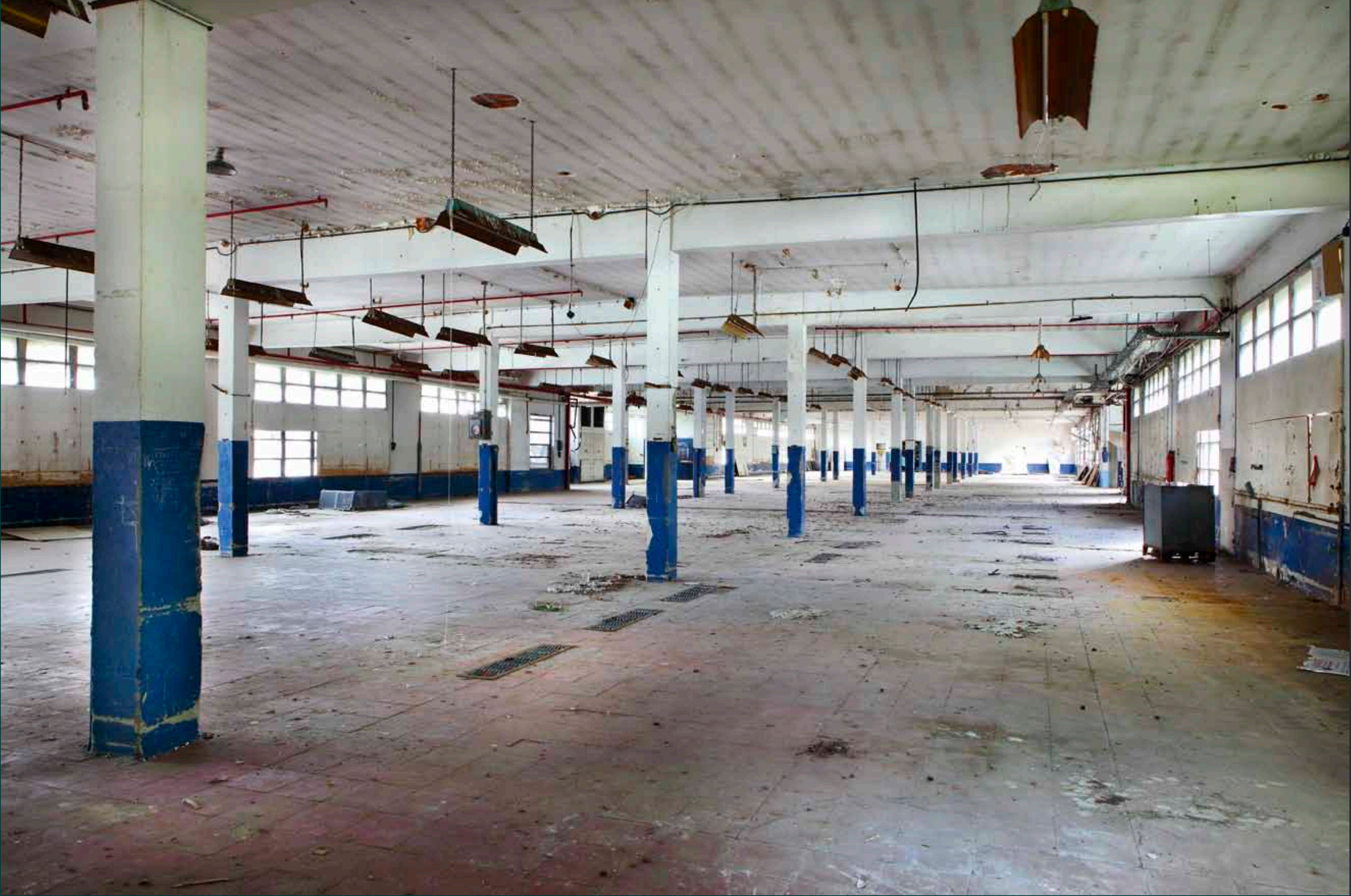
Vue intérieure de la filature. À l'intérieur du bâtiment, chaque niveau d'atelier consiste en un vaste plateau libre d'abord por de larges baies (en partie obturées aujourd'hui). La structure en béton permettait de supporter le poids des machines et d'encaisser leurs vibrations. Espace, lumière et robustesse sont les principaux besoins de l'architecture industrielle et ses premières qualités !
