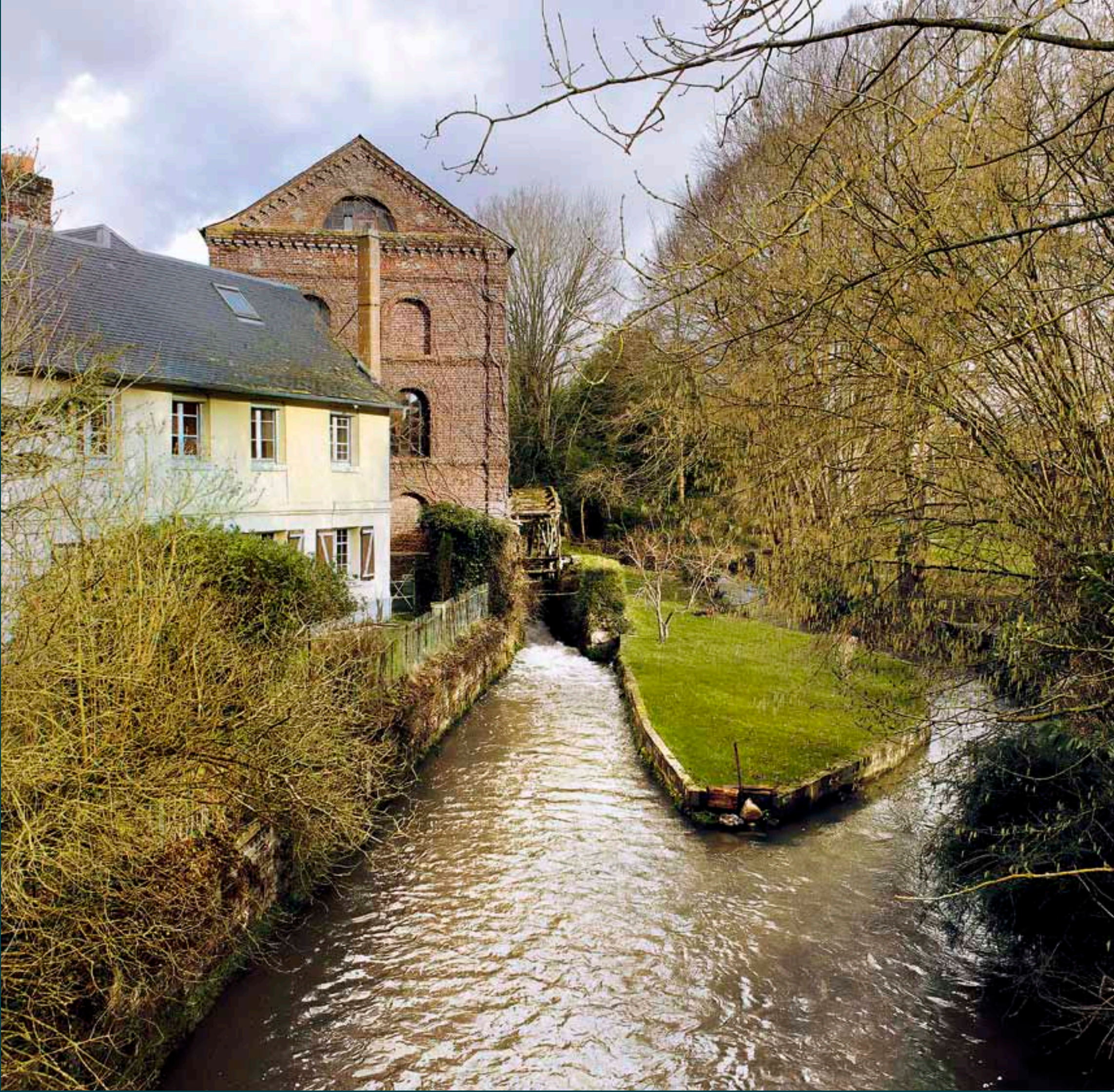
Fleury-sur-Andelle. Minoterie Laimé. La minoterie est construite sur un canal de dérivation qui rejoint un bras de l'Andelle à l'aval du moulin.
