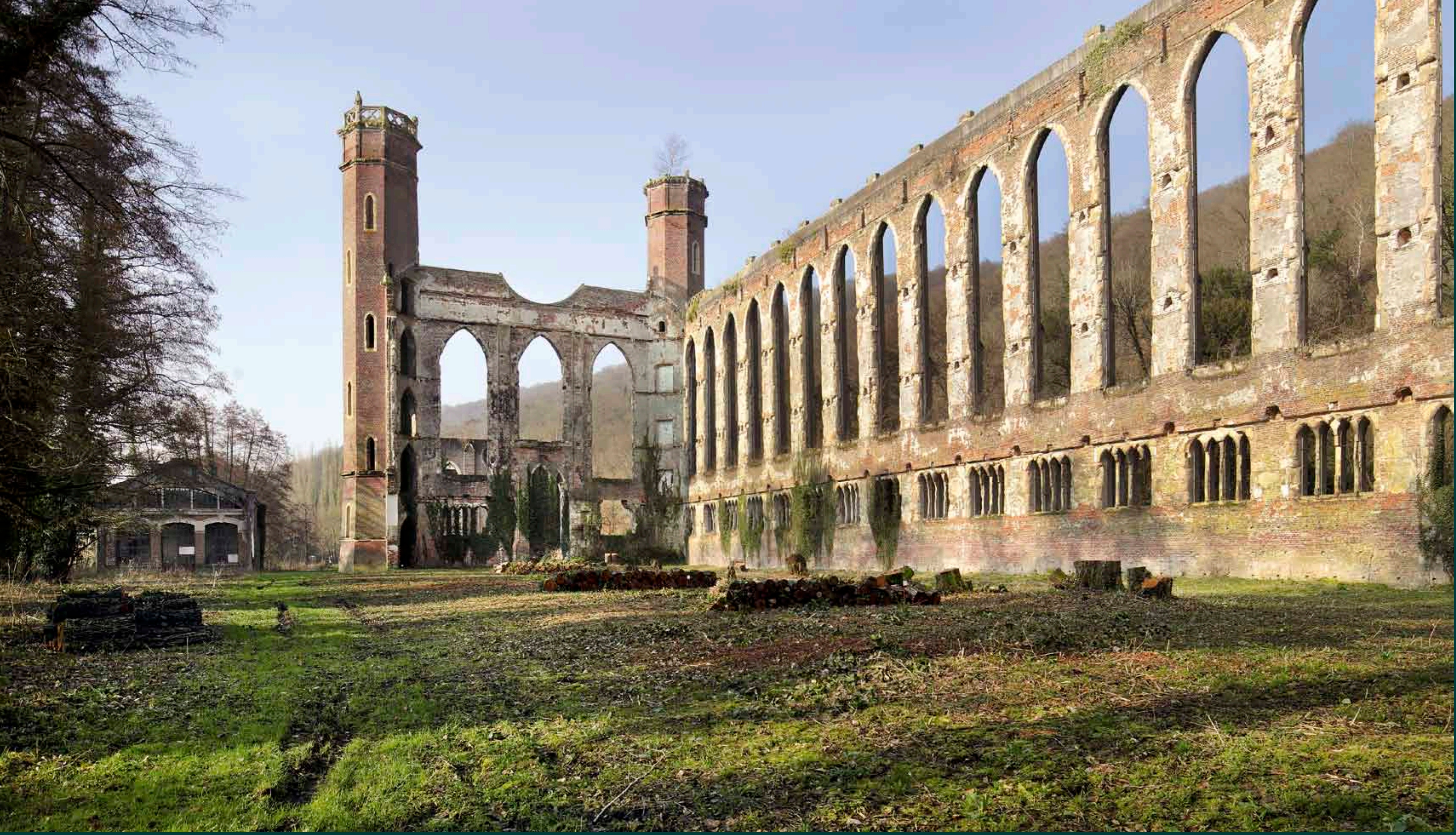
Vue des vestiges la grande filature depuis l'intérieur. La filature Levavasseur est détruite par un incendie en 1874, 13 ans après sa mise en activité. La malchance n'est pas seule à l'origine de ce sinistre. Prodiges sur l'apparence de son usine, Charles Levavasseur délaisse paradoxalement l'aspect technique du bâtiment. Il opte pour un système constructif tout en bois (poteaux, poutres, planchers), alors que l'emploi de la fonte réputée fireproof (résistante au feu) se généralise. Une conséquence impardonnable, dans un contexte où le feu est le premier fléau des usines textiles !
