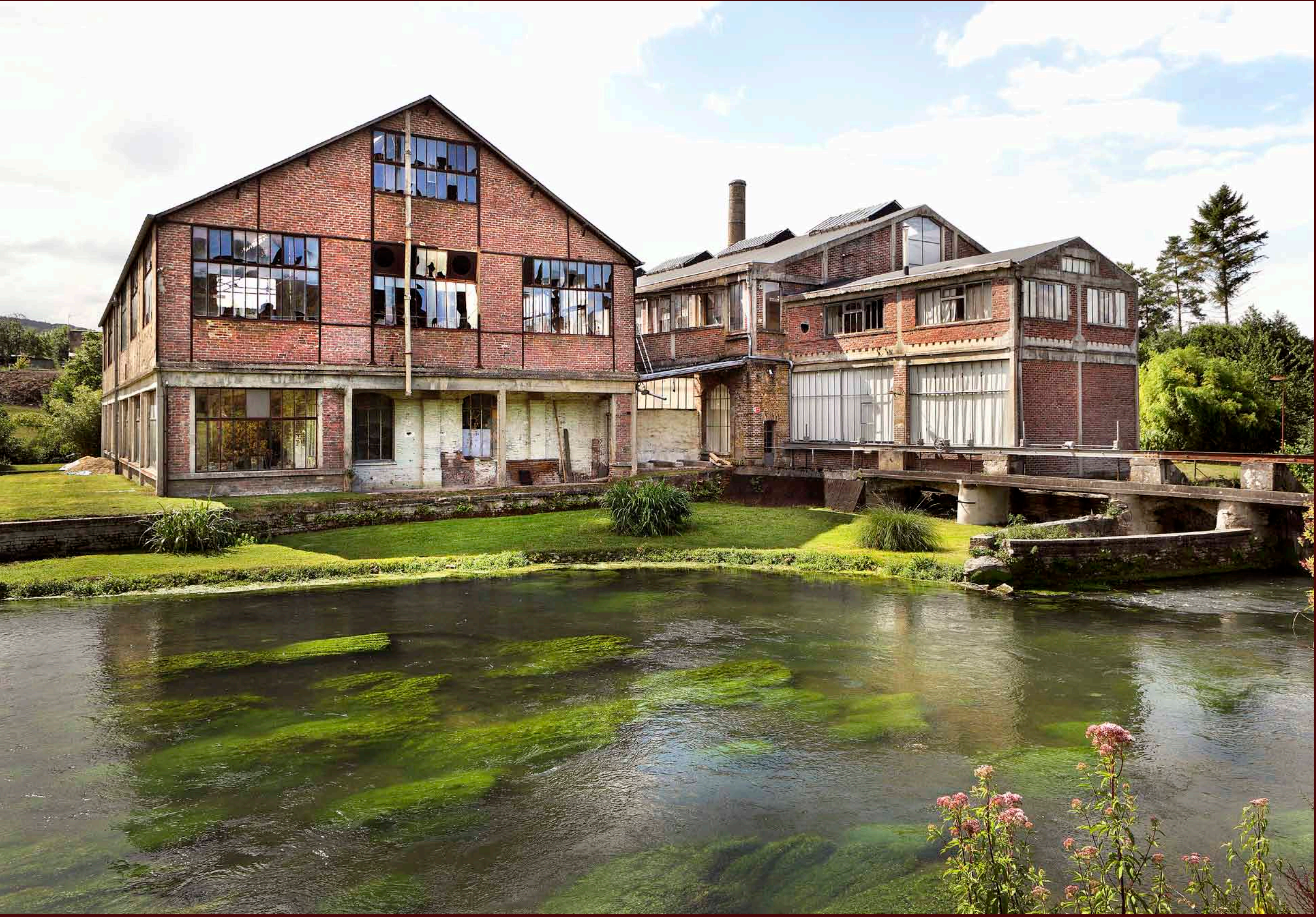
Vue de l'usine depuis la rive droite de l'Andelle. Les anciens ateliers de production sont reconvertis aujourd'hui en ateliers d'artistes.
