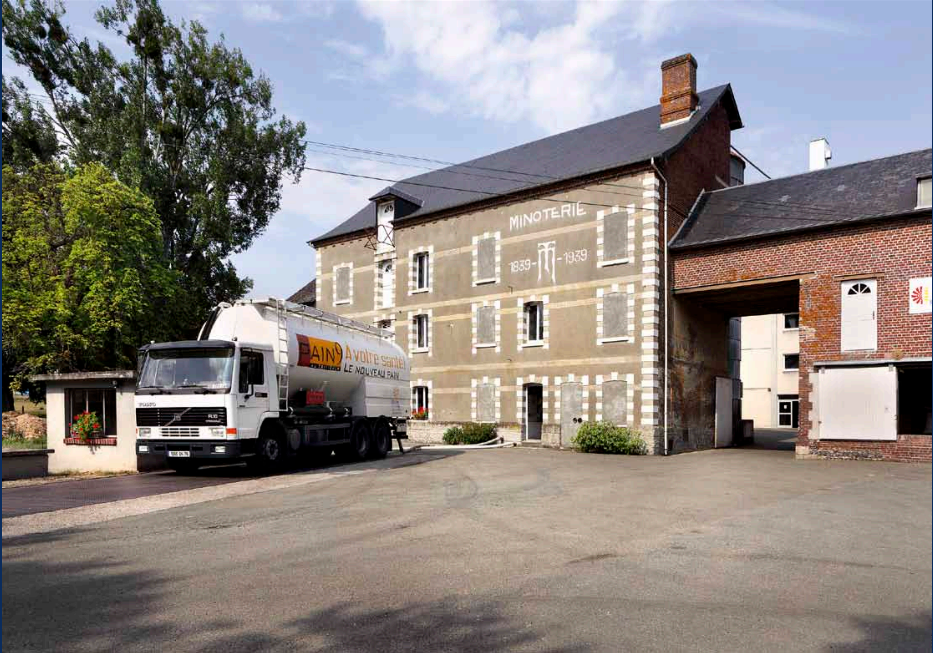
Façade du moulin primitif. Ce site a connu une évolution continue et plusieurs propriétaires depuis sa création en 1839 : d'abord moulin « à l'anglaise » fondé par M. Binier, il est repris par Edmond Dufour en 1891 et transformé en minoterie en 1901 avec l'installation de broyeurs à cylindres et d'une turbine puissante en remplacement des moulins traditionnelles et de la roue à aubes d'origine. En 1911, la minoterie est rachetée par Gaston Mouchard et depuis plus d'un siècle ses descendants en poursuivent l'exploitation.
