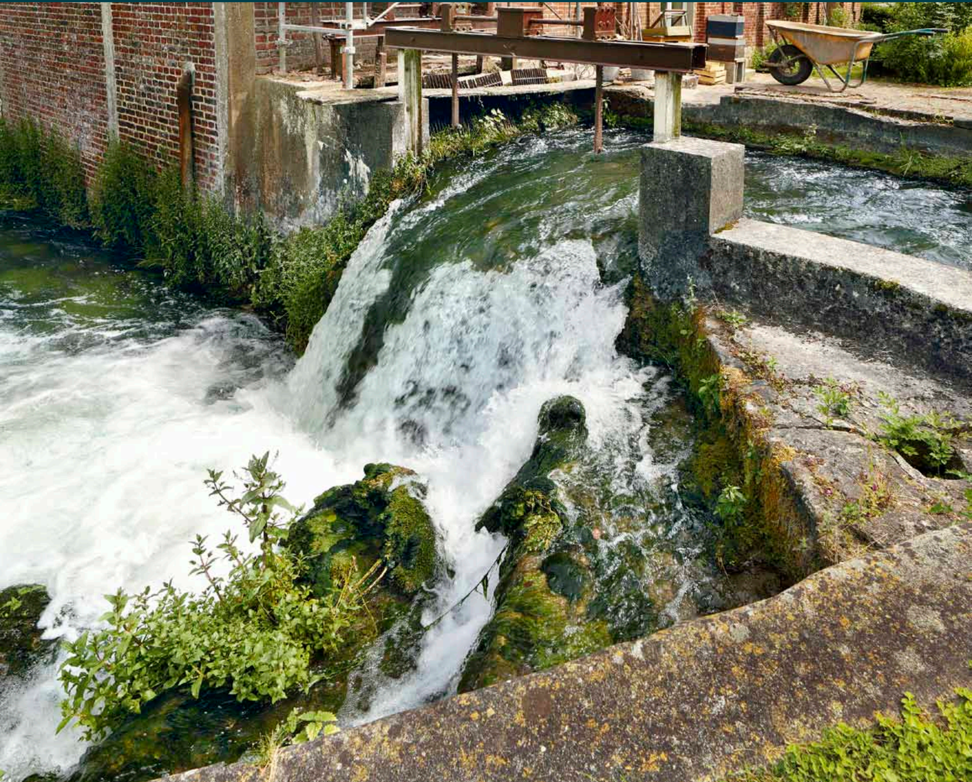
Saint-Denis-le-Thibault. Moulin à blé Crespin. En 1928, Amédée Crespin charge M. Massien, constructeur mécanicien à Charleval, de remplacer la roue de son moulin par une turbine. Le changement de moteur est effectué sans toucher aux ouvrages régulateurs en place. Vannage et déversoir sont conservés dans leur disposition et leur dimension primitives, de même que la chute maintenue à 2,5 m de hauteur.
