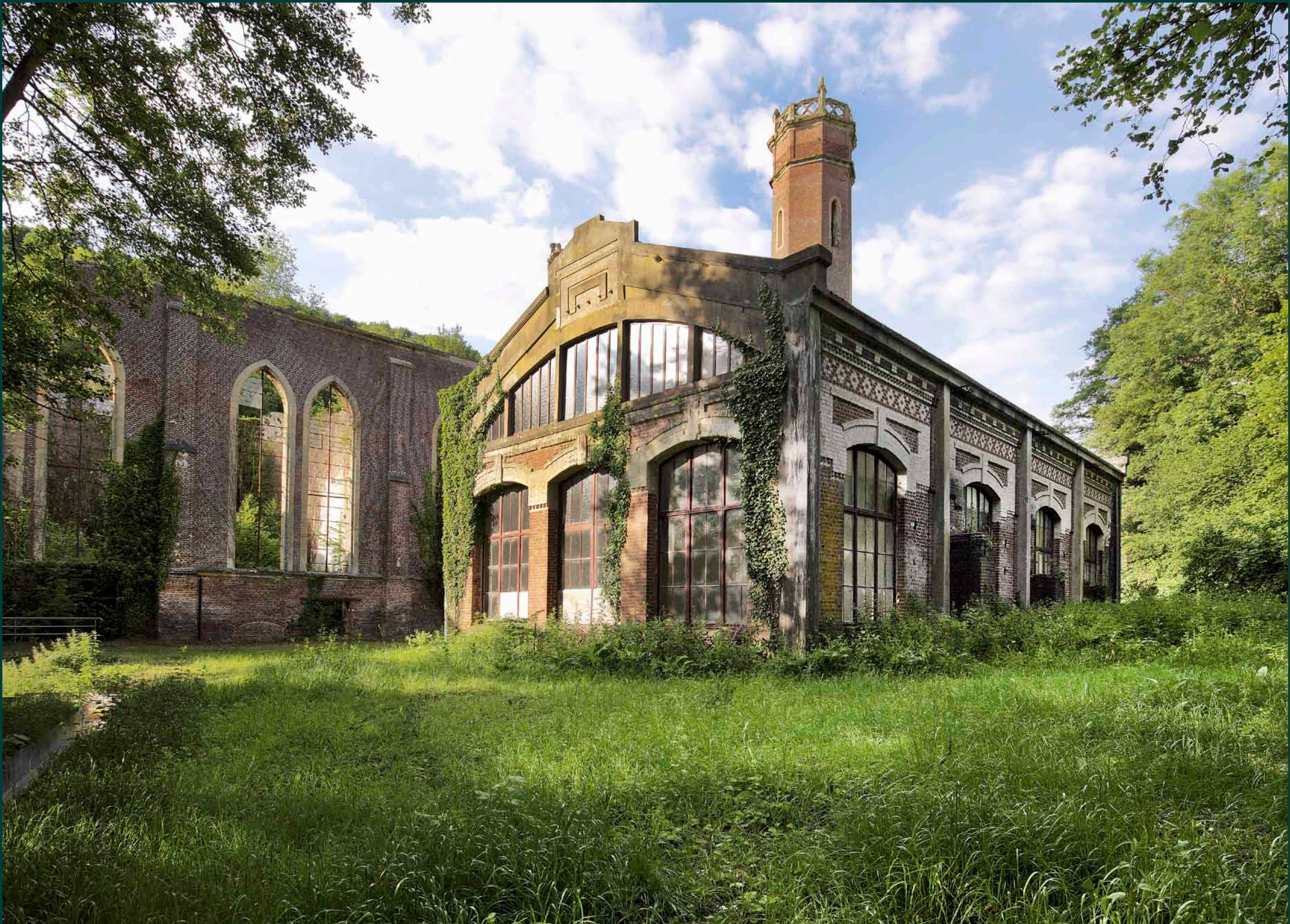
Vue du bâtiment des moteurs Diesel.
