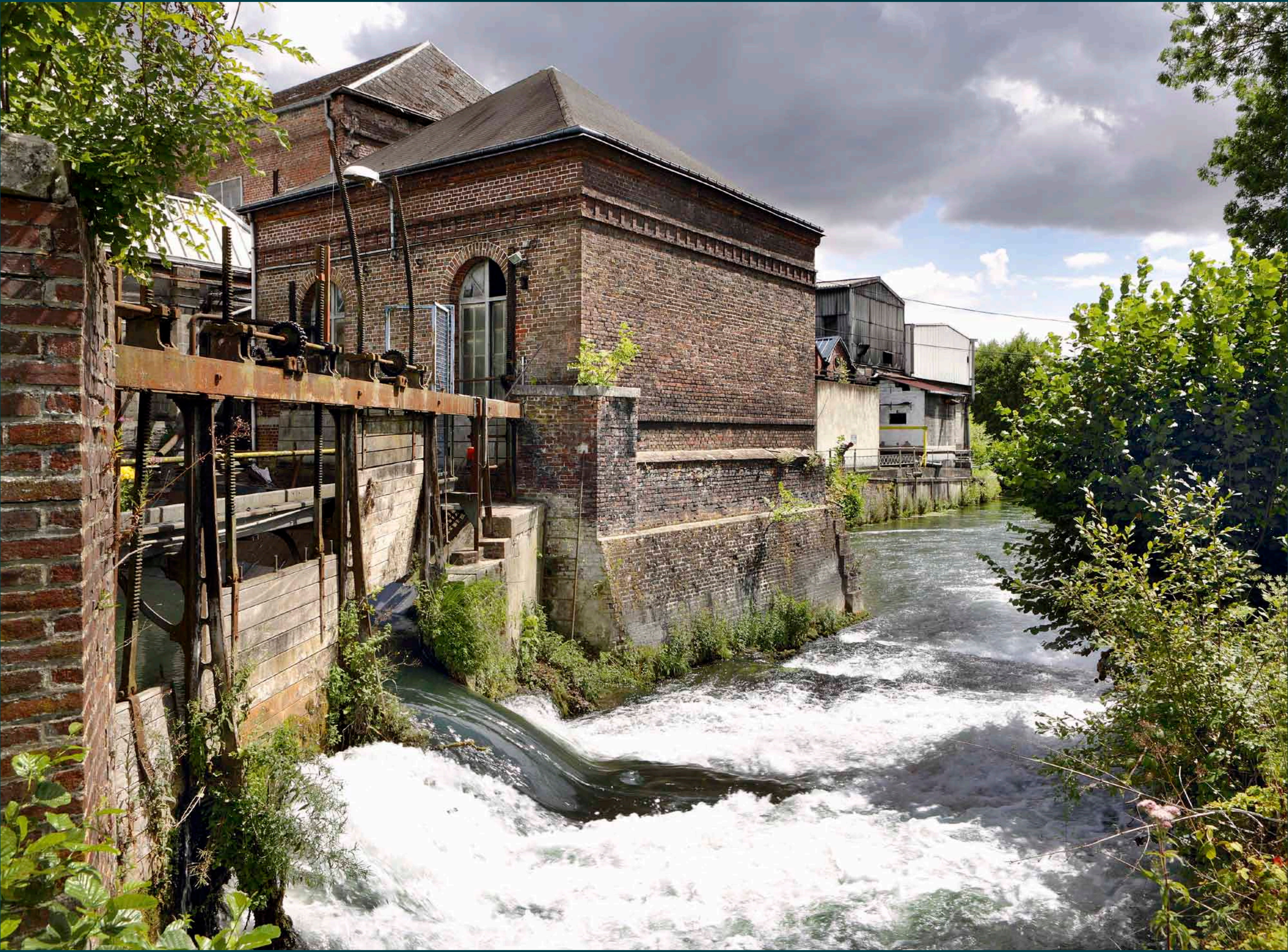
Charleval. Tissage de Transières. Juste en amont du petit bâtiment qui abrite la turbine de l'usine se trouve un grand vannage de décharge composé de trois vannes en bois autonomes mesurant chacune près de 2 m de large.
