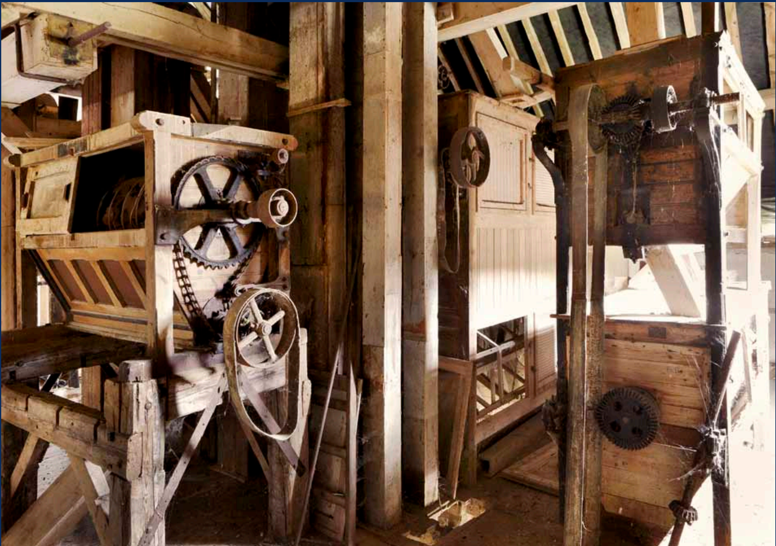
Blainville-Crevon. Minoterie Grivet. Les machines installées dans les combles servent à la fois au nettoyage et blutage du grain. Le nettoyage consiste à séparer le noyau et l'enveloppe du blé, le blutage à trier et tamiser la mouture en fonction de sa finesse.
