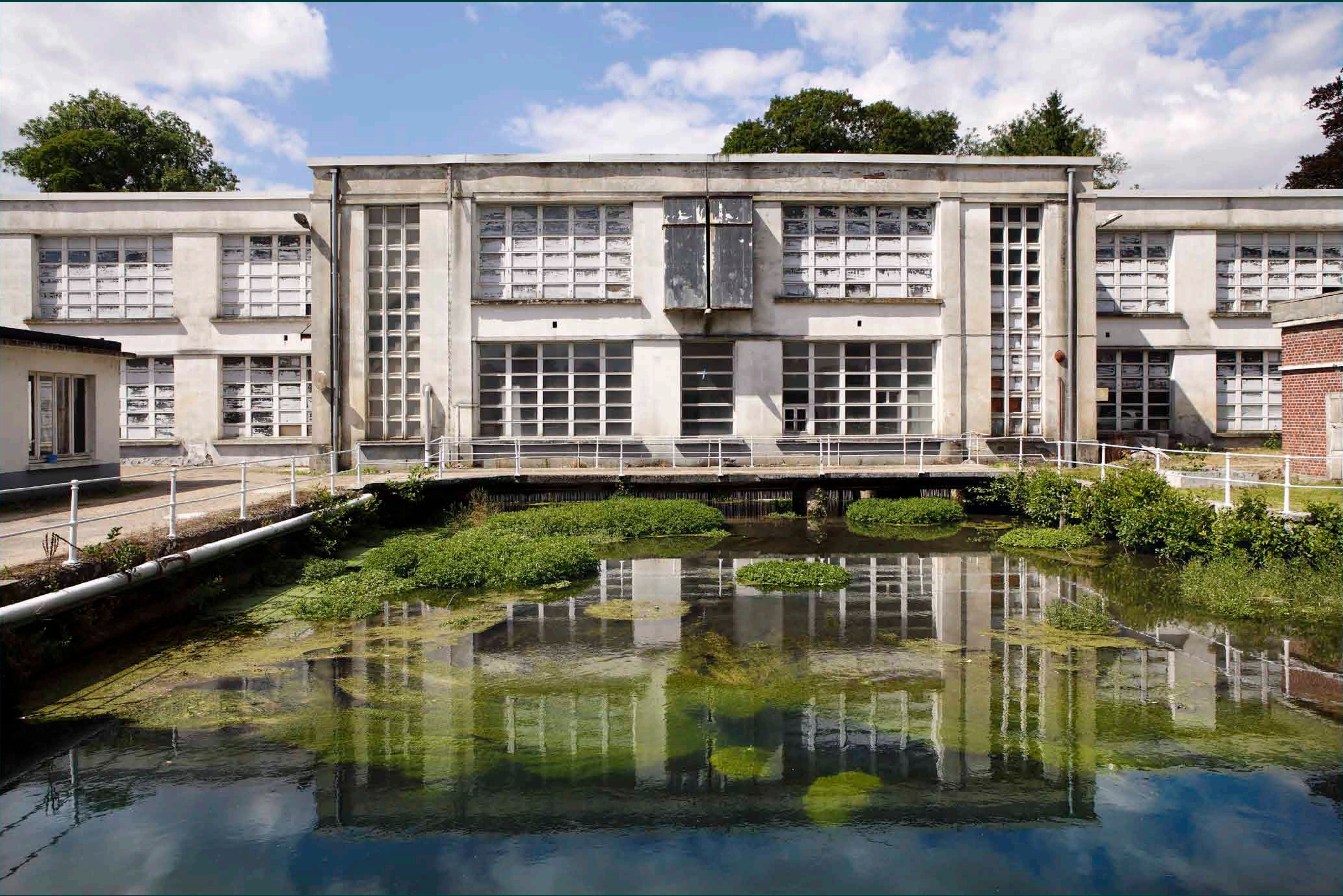
Détail de la façade de la filature. Cette filature est entièrement reconstruite dans les années 1950. Son architecture en béton et son style inspiré du courant moderne sont caractéristiques de cette époque.
