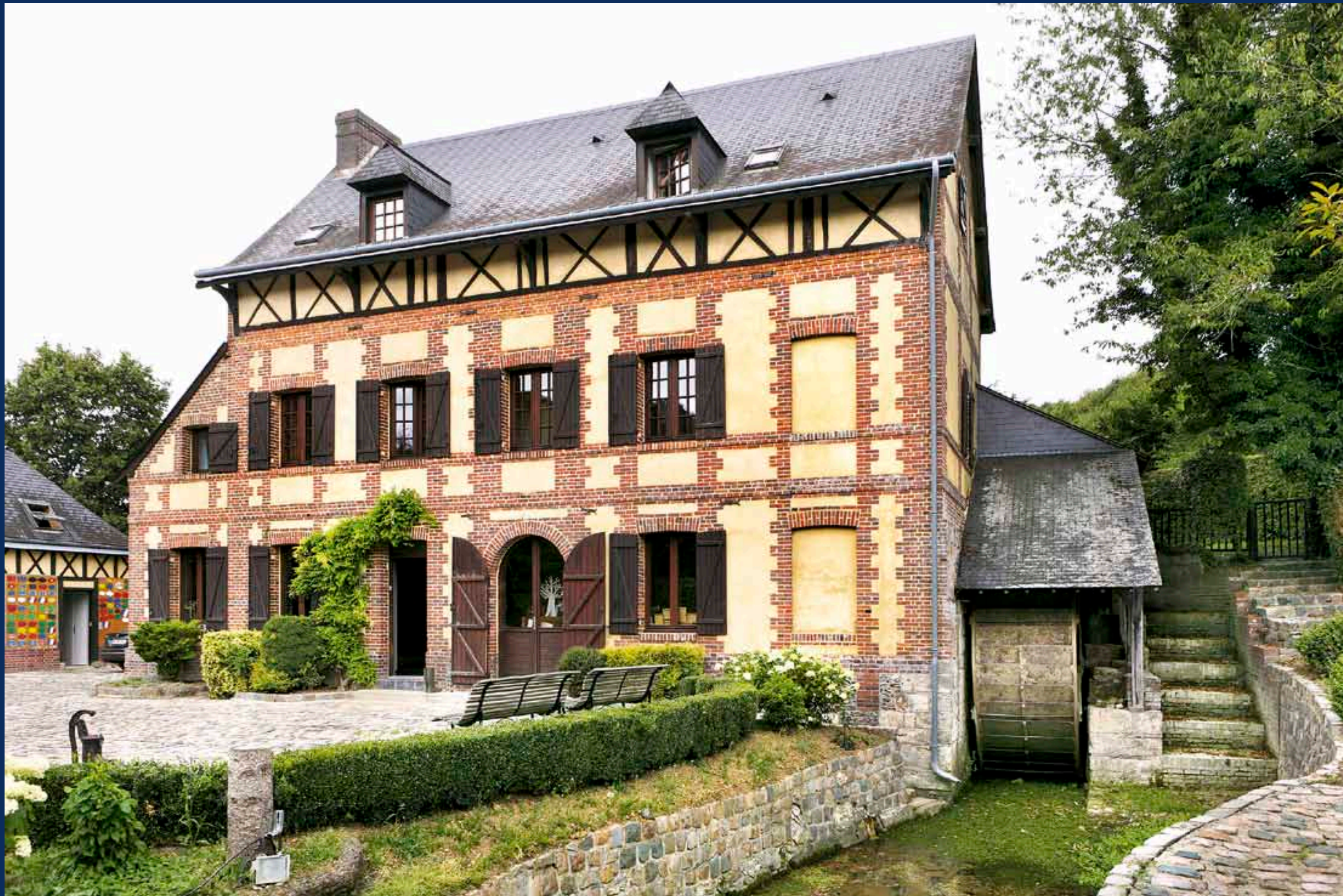
Rebets. Moulin de Boisguilbert, 1819. À la fin du XIX e siècle le moulin est modernisé et transformé en minoterie. Les meules en pierre et la roue en bois par-dessus sont remplacées par des broyeurs à cylindres et une roue métallique par-dessous.
