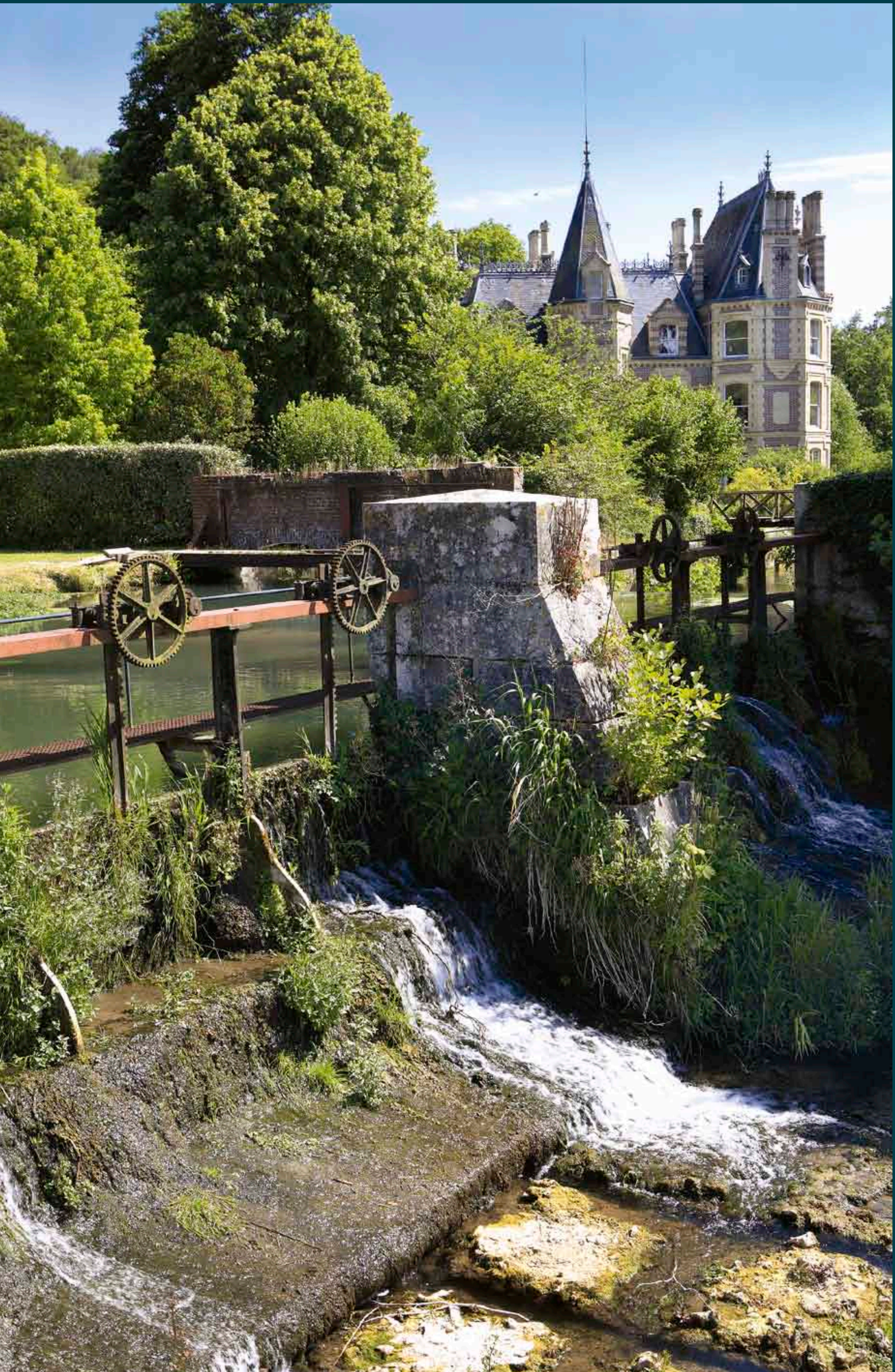
Perruel. Vestiges de la filature la Rouge. Cette imposante usine détruite pendant la Seconde Guerre mondiale était équipée d'une turbine alimentée par deux chutes de 2,33 m de hauteur dont les aménagements sont encore visibles aujourd'hui.
