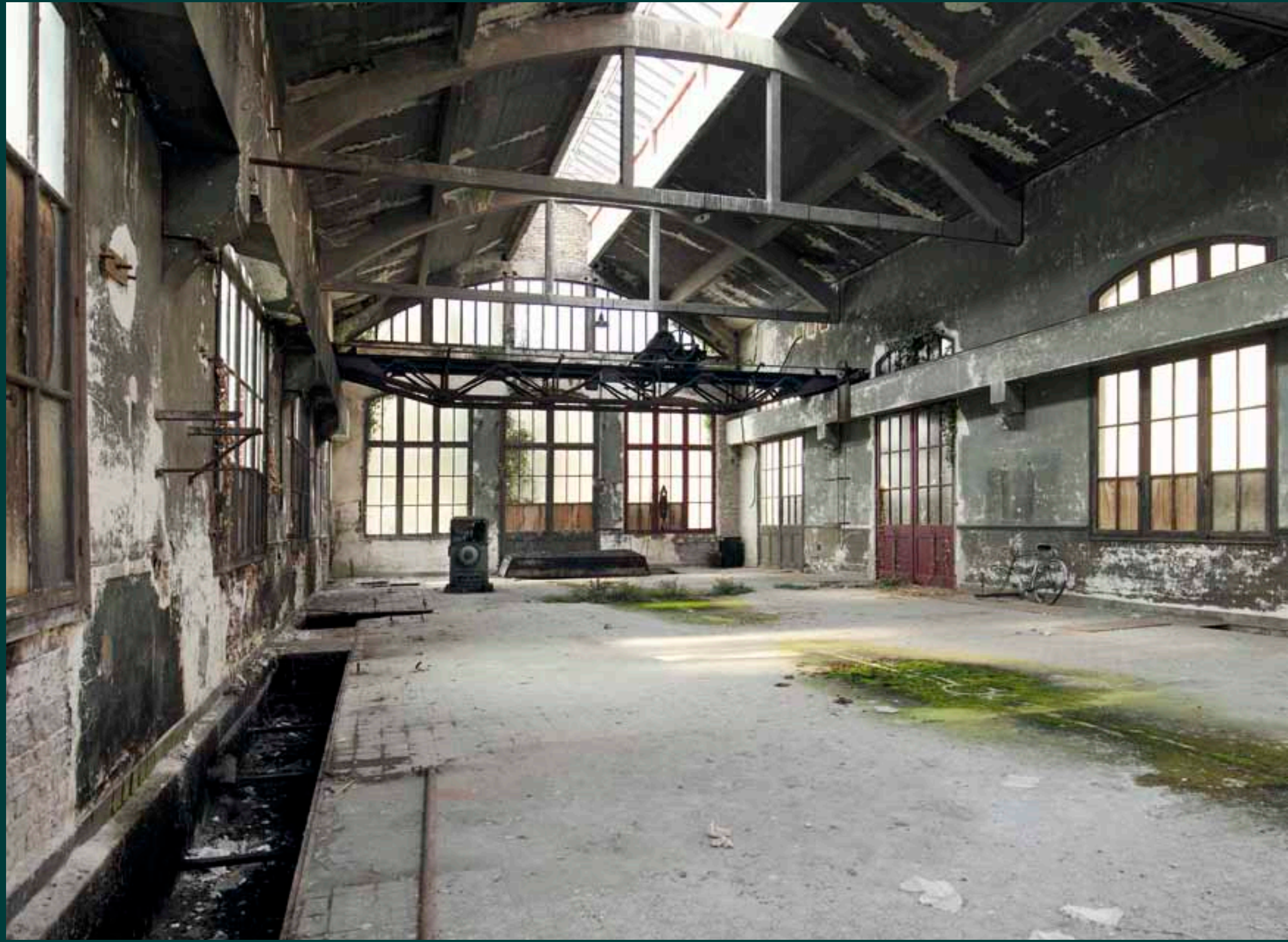
Vues intérieure du bâtiment des moteurs Diesel.
