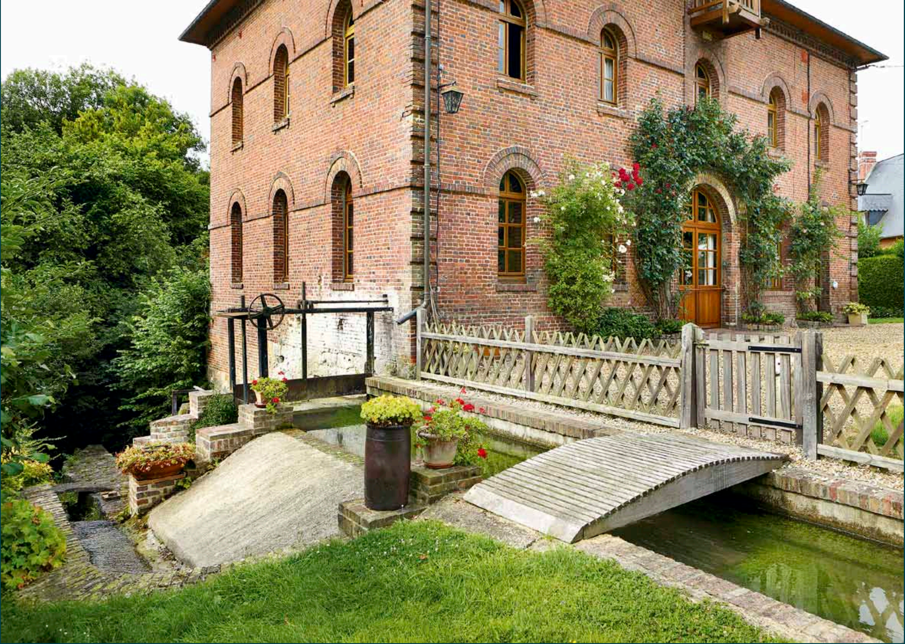
Saint-Germain-des-Essourts. Moulin à blé de Fontaine-Châtel. On distingue au premier plan le canal d'amenée qui conduit l'eau du Crevon sur le dessus de la roue hydraulique. L'arrivée d'eau est régulée par un déversoir en pente par lequel s'échappe le trop-plein et par une vanne d'alimentation placée juste en amont de la roue.
