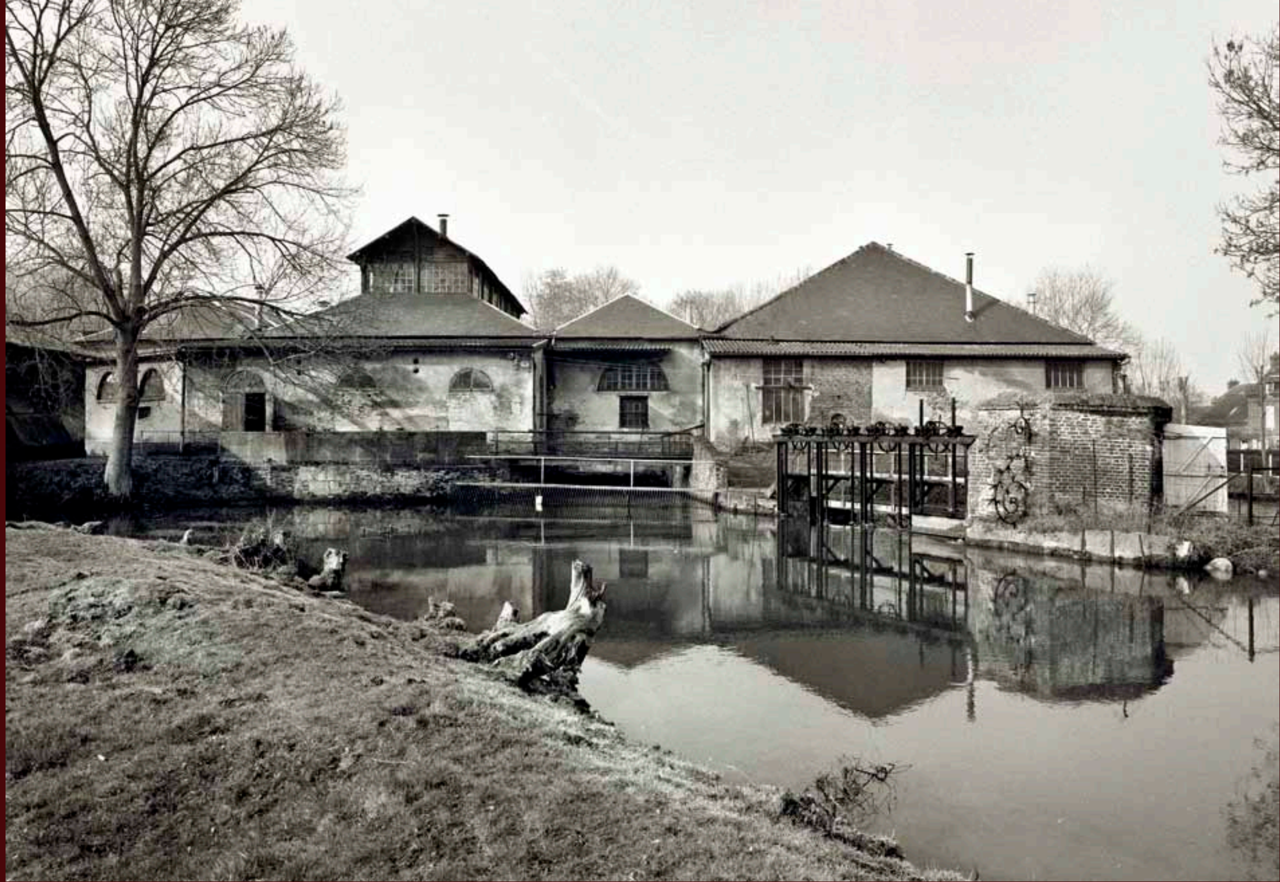
La taillanderie en 1985. L'usine Bétille, construite en 1823 par les Fonderies de Romilly comme laminoir du cuivre, devient en 1901 la taillanderie Soubeyran. Peu après son installation, Adrien Soubeyran remplace la roue hydraulique de l'usine par une turbine d'une puissance supérieure. L'énergie hydraulique (complétée par l'électricité dans les années 1970) est utilisée jusqu'en 1986 pour faire mouvoir les machines. L'usine primitive, abandonnée en 1993, est détruite à l'exception d'une grande halle aujourd'hui en cours de restauration.
