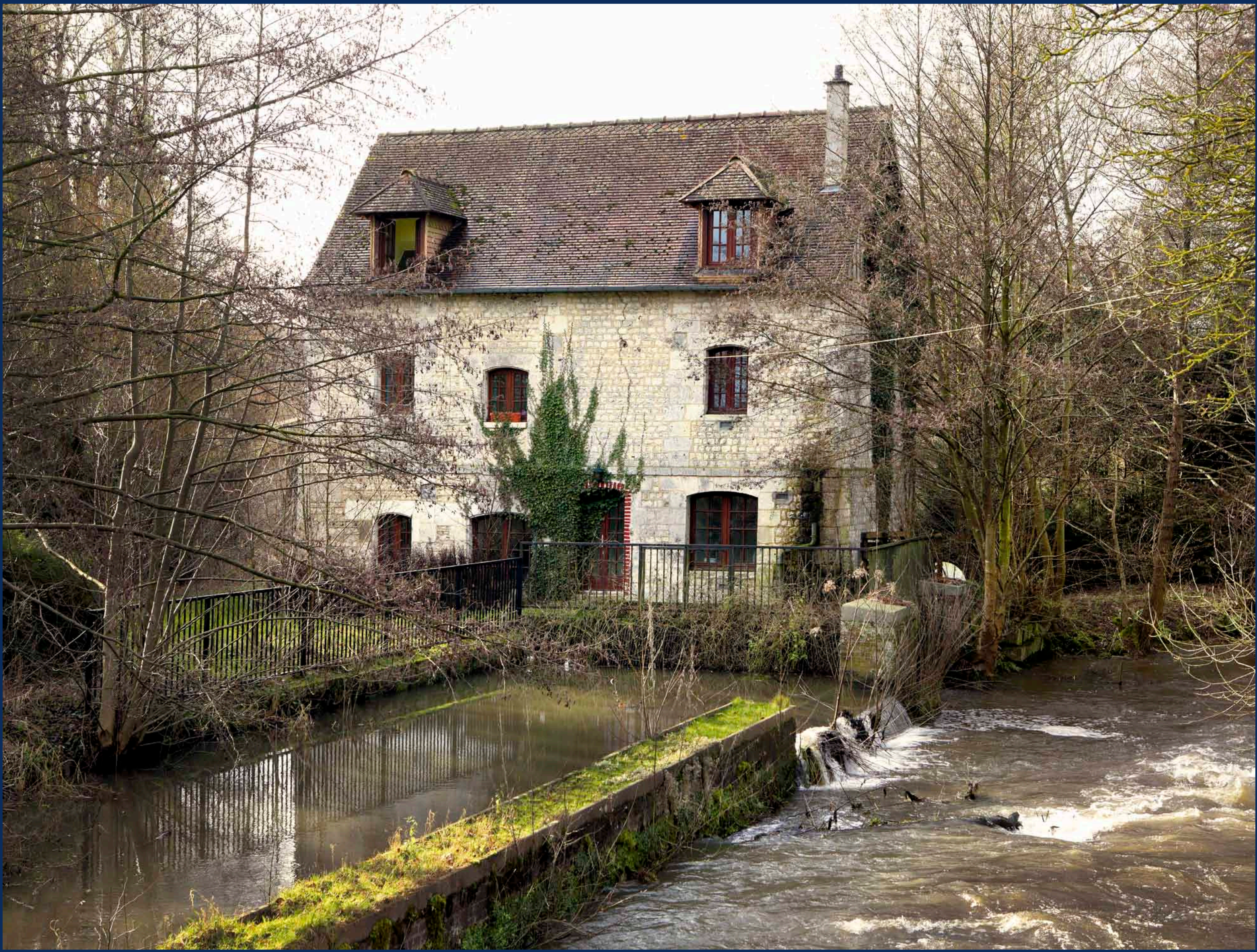
Radepont. Moulin du Pont, XVIII e siècle. Cet imposant moulin construit en pierre calcaire est bâti au début du XVIII e siècle par le marquis de Radepont. Il est racheté en 1821 par le baron Jacques Levavasseur, propriétaire des usines de Fontaine-Guérard. Au premier plan, on distingue parfaitement le canal d'alimentation maçonné qui alimentait la roue aujourd'hui disparue.
