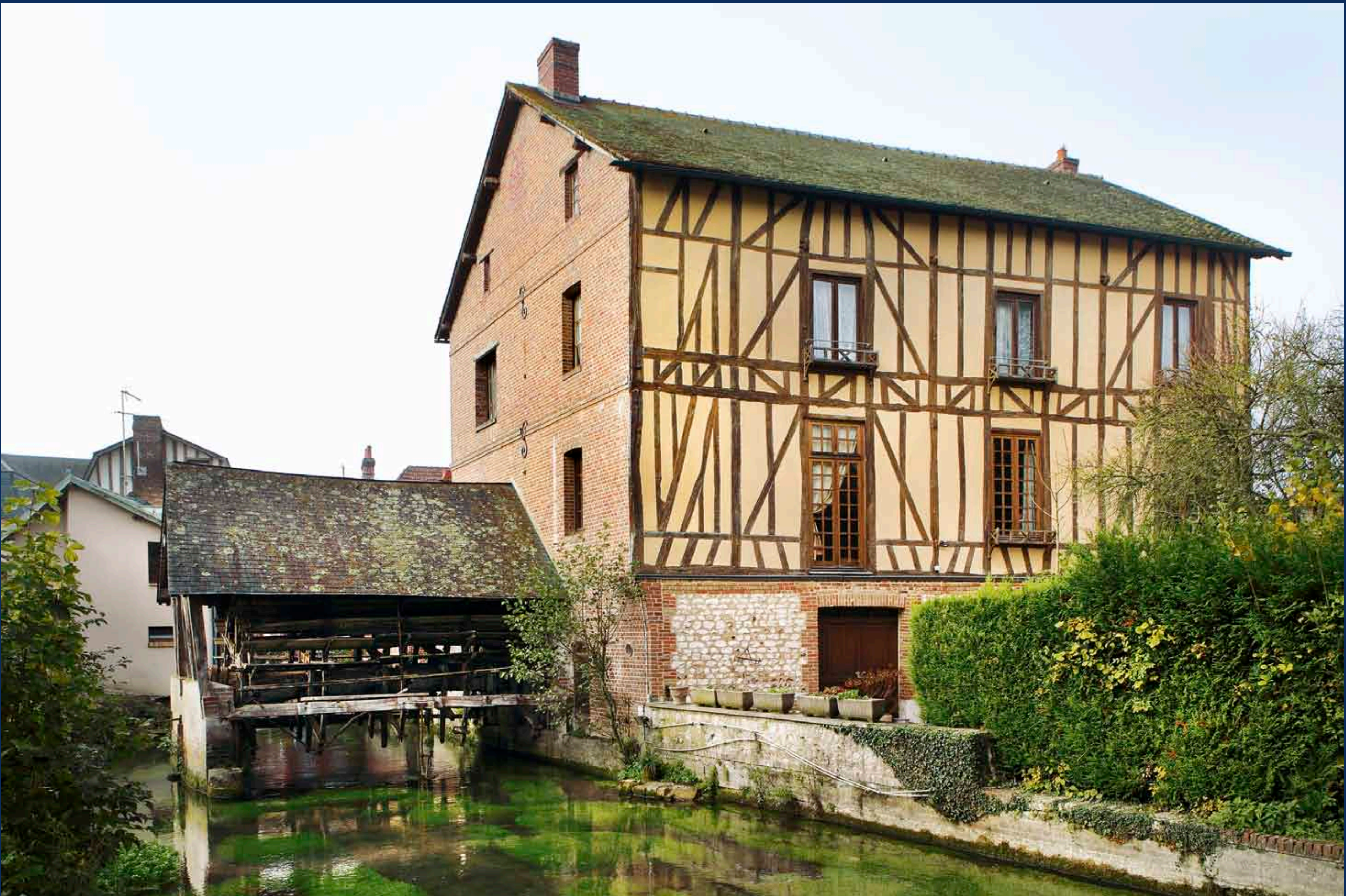
Pont-Saint-Pierre. Moulin Dehors, 1791. La roue actuelle est installée en 1821 lors de travaux d'extension du moulin entrepris par Ange Augustin Dehors, aubergiste et meunier, qui en est alors propriétaire. Cette roue de très grande dimension et de forte puissance doit lui permettre d'utiliser son moulin conjointement pour la mouture du blé et pour la fabrication de draps de laine. Suite aux plaintes récurrentes des usiniers d'aval, cette seconde activité est rapidement arrêtée.
