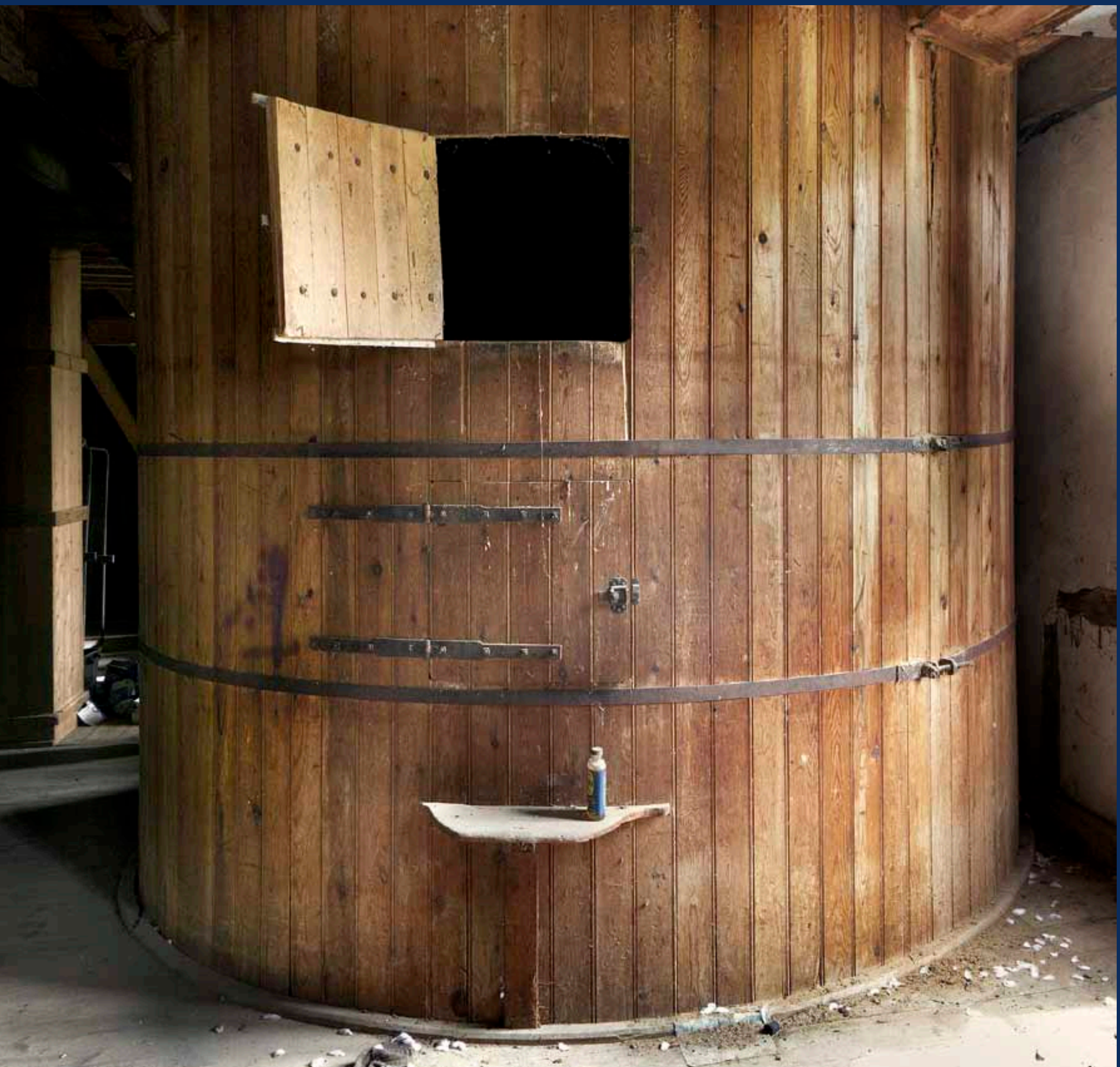
Blainville-Crevon. Minoterie Grivet. Ce silo cylindrique situé au 3 e étage de la minoterie servait au stockage du son, c'est-à-dire l'enveloppe du grain séparée du noyau, seul ce dernier étant utilisé pour la mouture.
