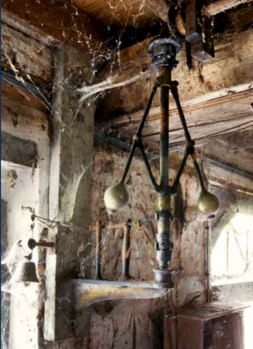
Saint-Denis-le-Thibault. Moulin Crespin. Le régulateur à boules permettait de contrôler la vitesse de rotation de la turbine hydraulique et des axes de transmission entraînant les machines afin d'éviter que celles-ci ne s'engorgent.
