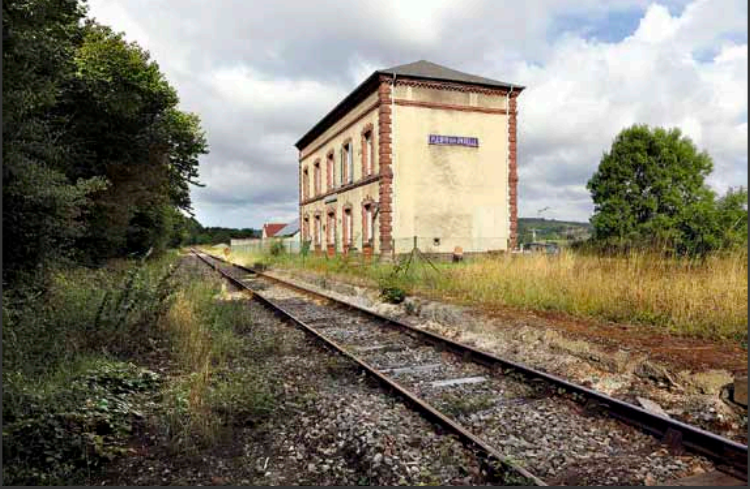
Gare de Fleury-sur-Andelle sur la ligne Gisors - Pont-de-l'Arche, carte postale vers 1920 et vue actuelle. Les gares du tronçon Lisors - Pîtres, construites au milieu des années 1860 par la Compagnie du chemin de fer de Pont-de-l'Arche à Gisors, présentent une architecture très simple avec des façades recouvertes d'enduit et quelques décors en brique (chainage d'angle et encadrement des baies). La ligne Gisors - Pont-de-l'Arche est fermée aux voyageurs en 1956 mais sert encore ponctuellement pour le trafic fret de la sucrerie d'Etrépagny.
