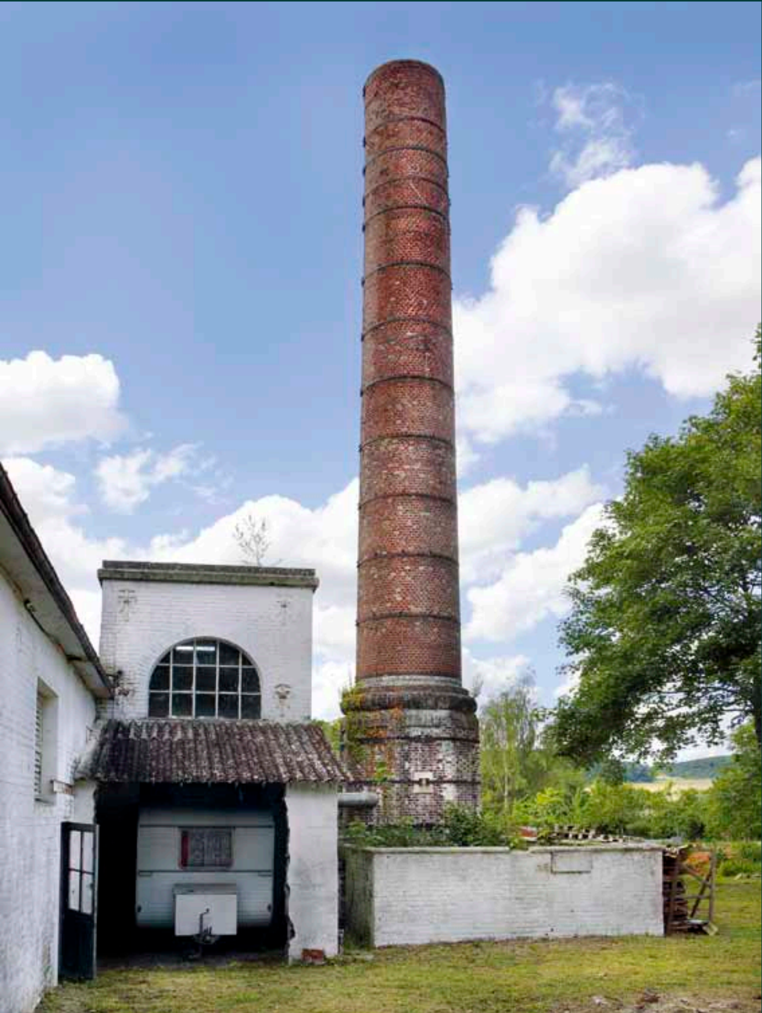
Ateliers et bâtiment de la turbine. Le bâtiment de la turbine, à cheval sur la rivière, est accolé aux ateliers pour faciliter la distribution de la force motrice jusqu'aux machines.
