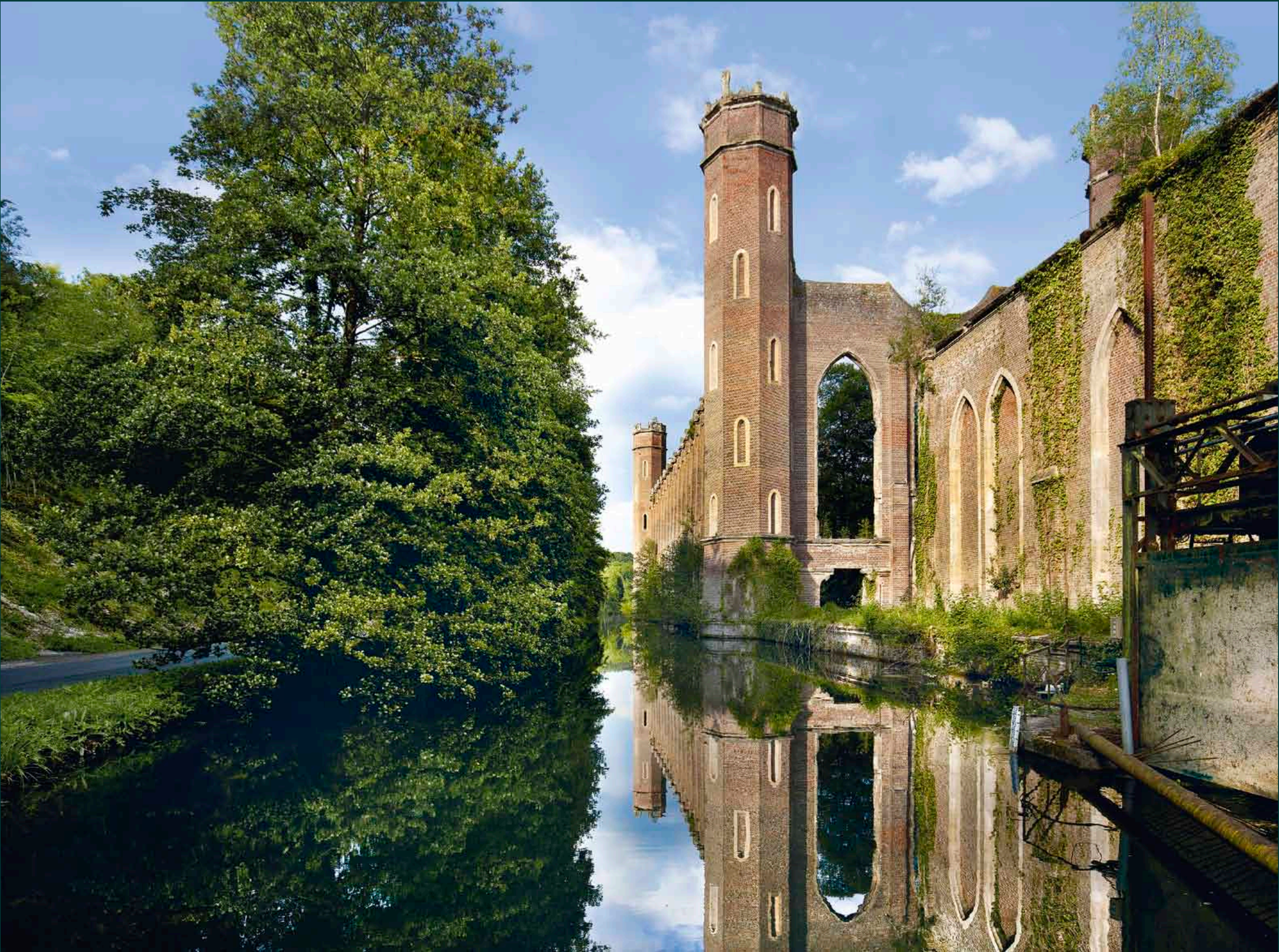
Vue des vestiges de la grande filature depuis le canal d'aménée. La filature Levavasseur utilise conjointement l'énergie thermique fournie par deux machines à vapeur et l'énergie hydraulique de l'Andelle pour entraîner une turbine hydraulique de 200 chevaux. Cette dernière est alimentée par un immense canal de 10 à 15 m de large et de 500 m de long.
