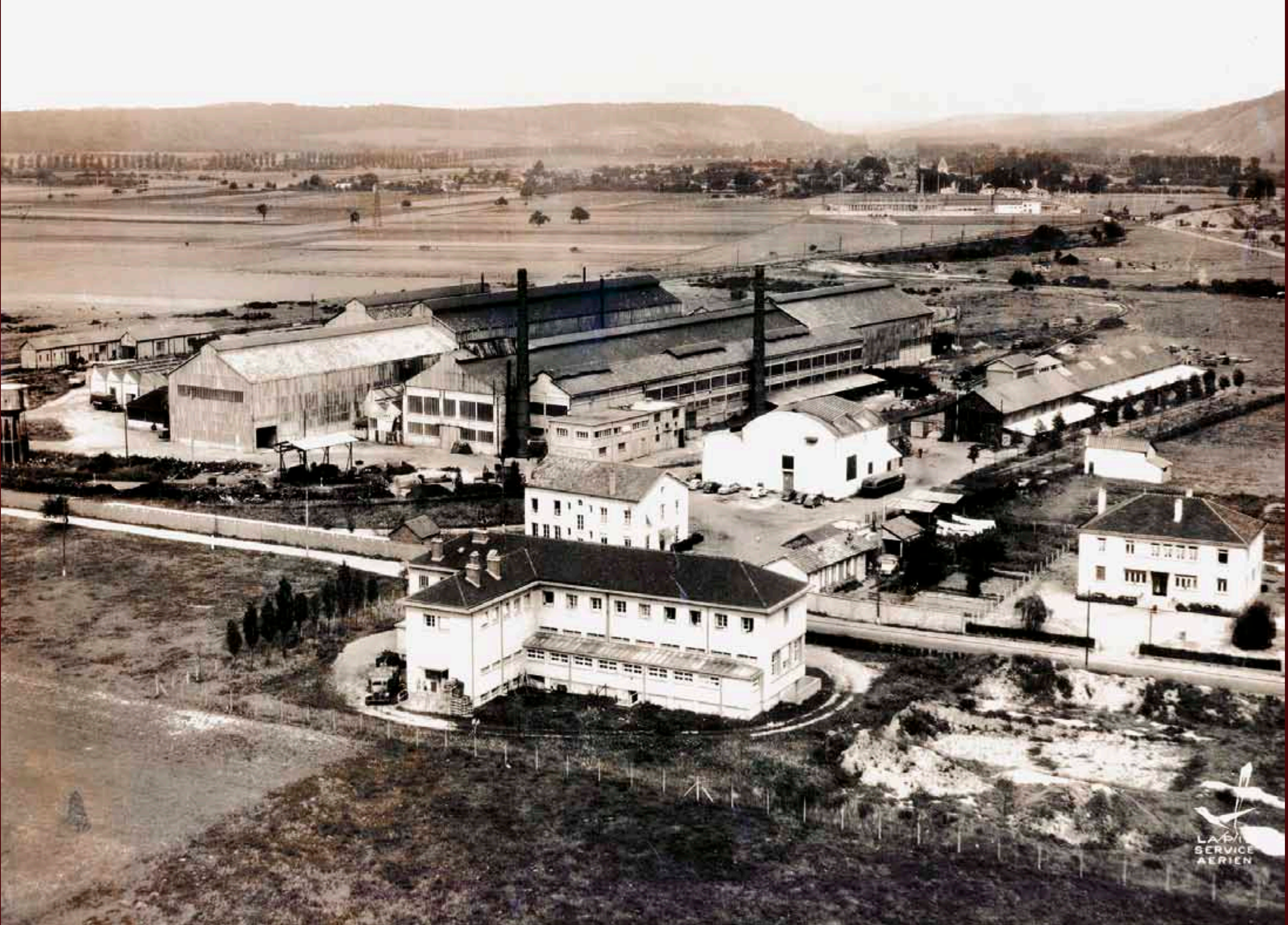
Vue aérienne, vers 1950 (Coll. Manoir Industrie). Les innovations opérées dans les années 1950 pour développer notamment la production d'aciers spéciaux nécessitent la construction de nouveaux bâtiments, de type « grande halle » c'est-à-dire de plain-pied et avec une importante hauteur sous toiture. L'usine couvre alors 13 500 m². Suite à cette extension, son effectif passe à 510 personnes.
