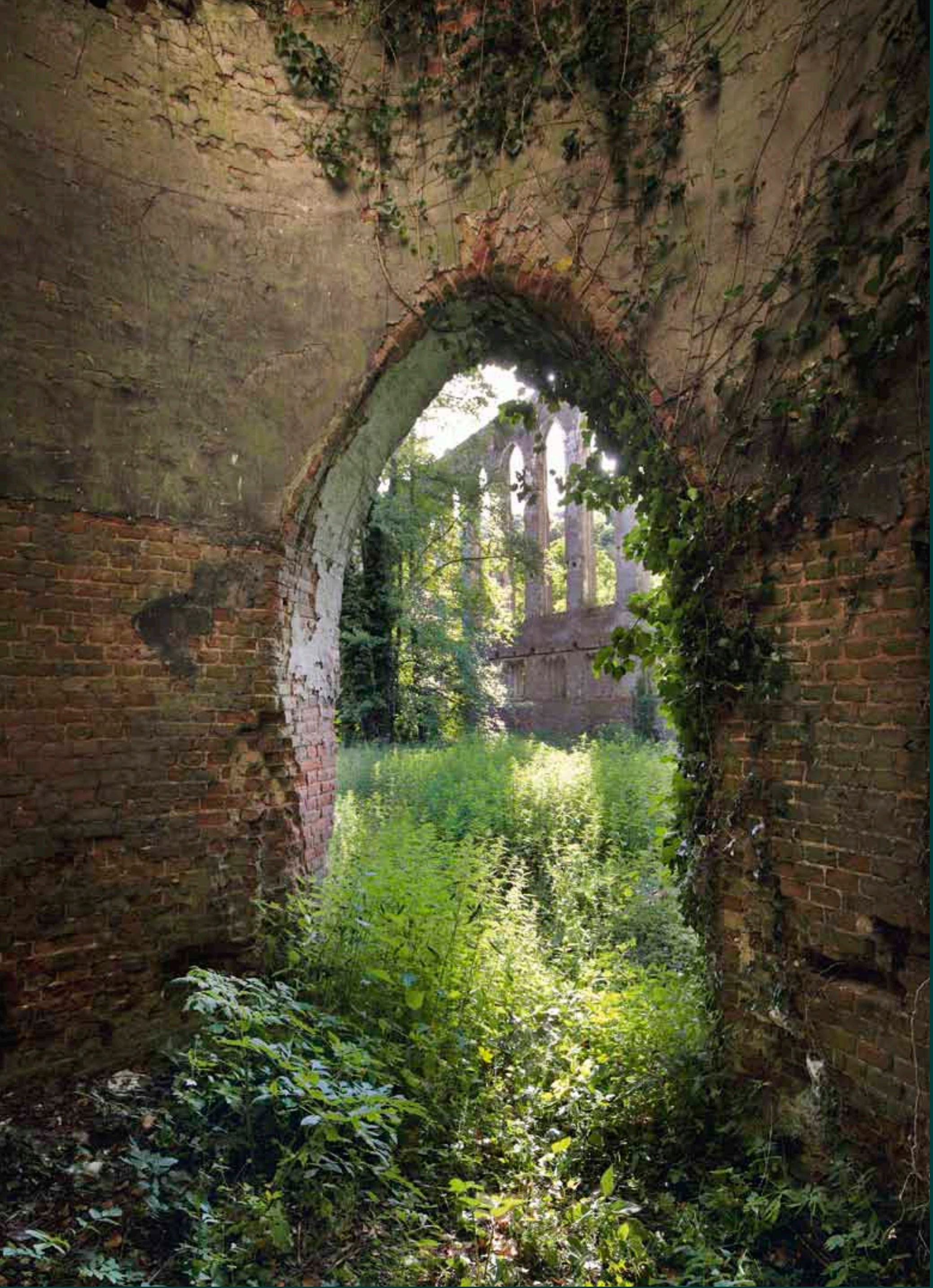
Vue intérieure d'une tour servant de cage d'escalier.
