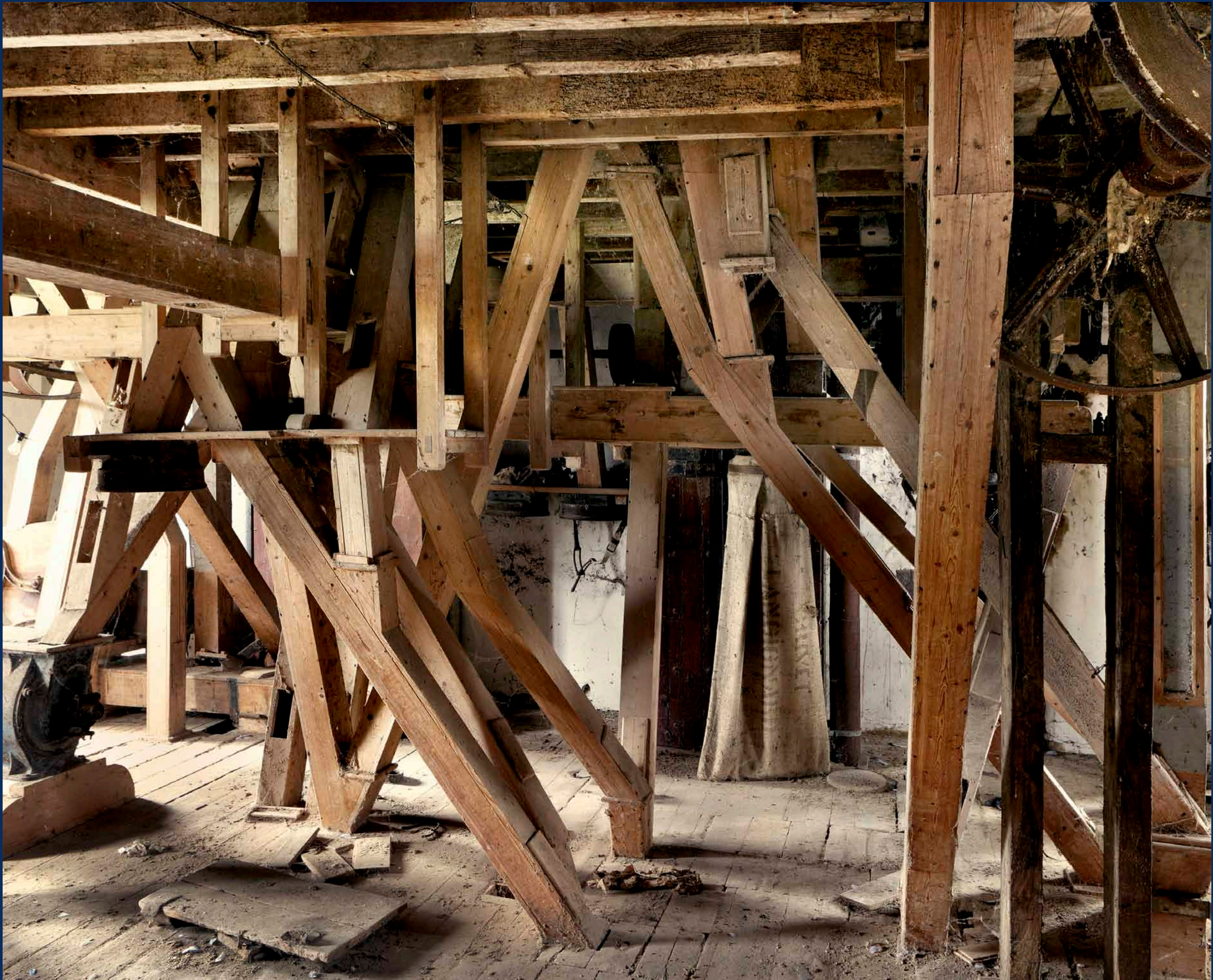
Blainville-Crevon. Minoterie Grivet. Ce système élévateur à godets protégé par un carénage en bois permettait d'acheminer la mouture dans tous les étages de la minoterie pour lui faire subir plusieurs écrasements jusqu'à obtention de la finesse de farine voulue.
