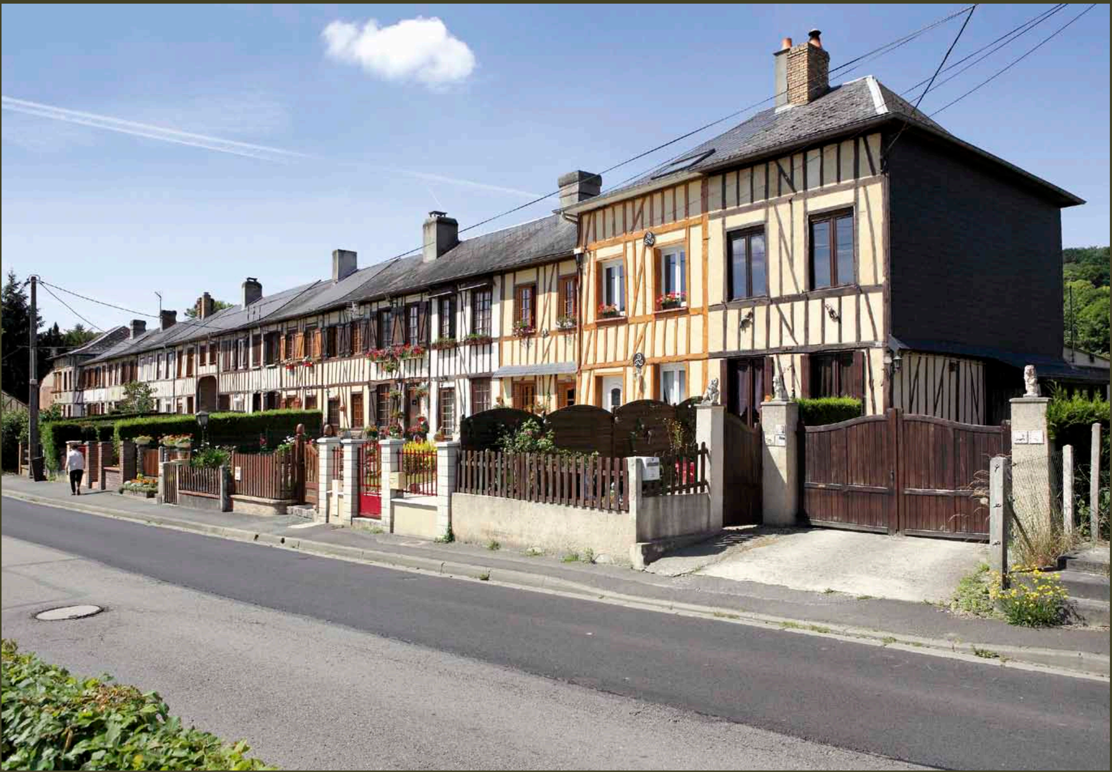
Logements ouvriers à Perriers-sur-Andelle. Cette série de logements ouvriers est encadrée de logements de contremaîtres bâtis sur le même modèle mais de taille plus généreuse. Construite en pan de bois, elle était destinée aux employés de la filature d'Alexandre de Montlambert fondée en 1827.
