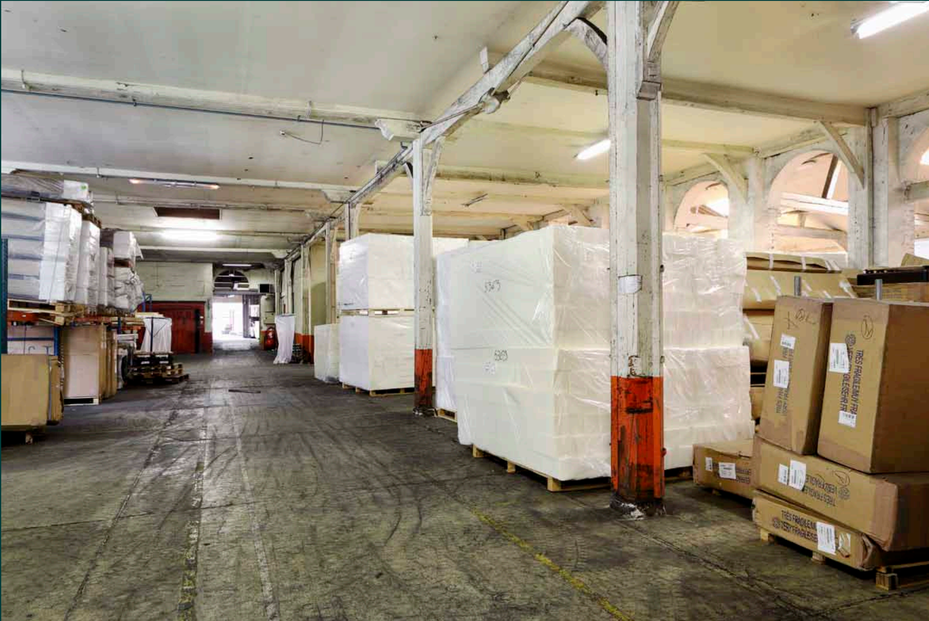
Vue intérieure de l'ancienne filature au moment où elle était utilisée comme lieu de stockage par le groupe Copirel-Epéda. On distingue parfaitement le système d'assemblage poteaux-poutres en bois qui constitue l'ossature de cette filature édifiée en 1845.
