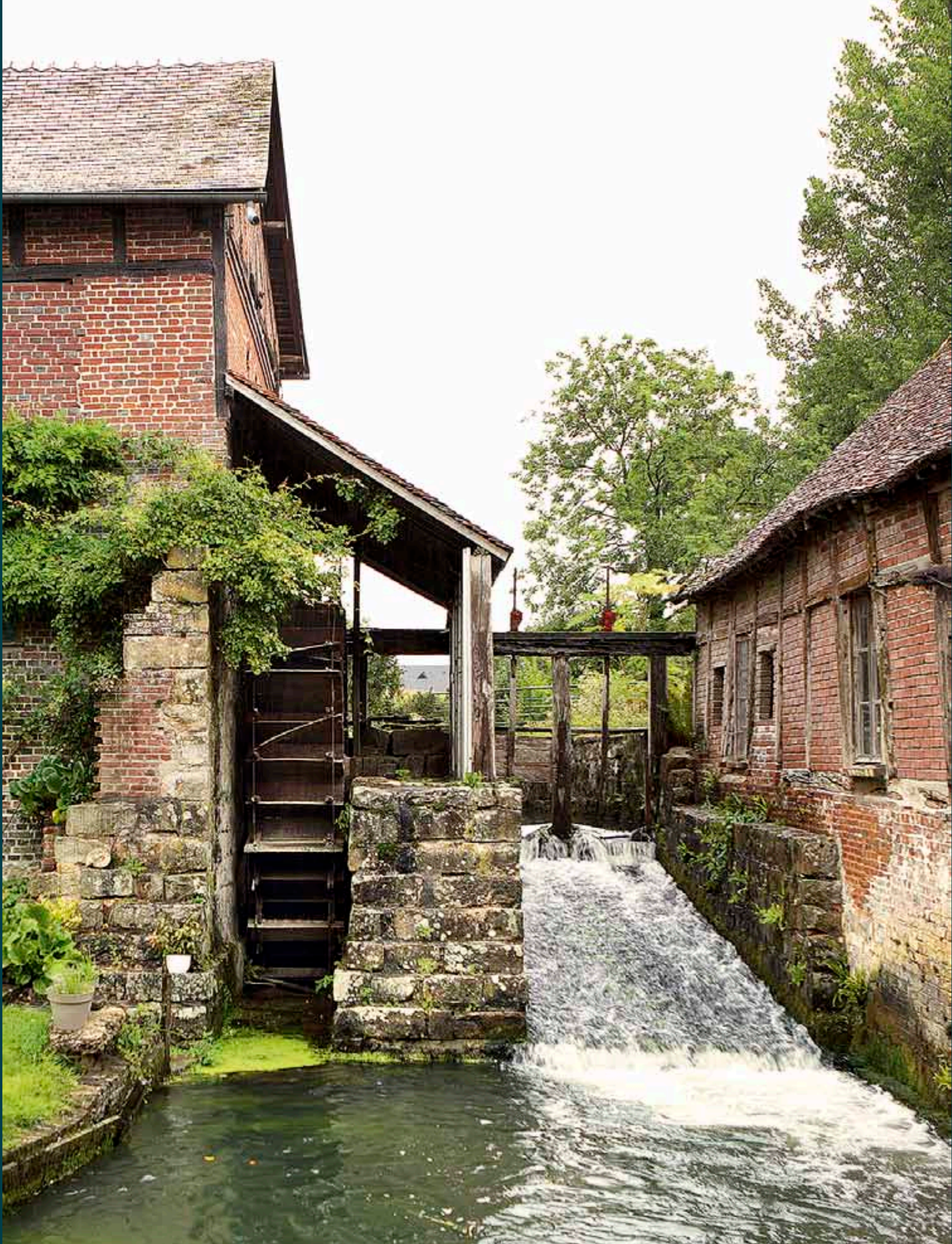
La Hallotière. Moulin de Normanville. Roue hydraulique par-dessous à aubes planes en bois, de 4,50 m de diamètre et 1 m de largeur, d’une puissance de 50 000 kWh. On parle de roue par-dessous quand l’eau vient frapper les aubes et actionne la roue en passant sous elle.
