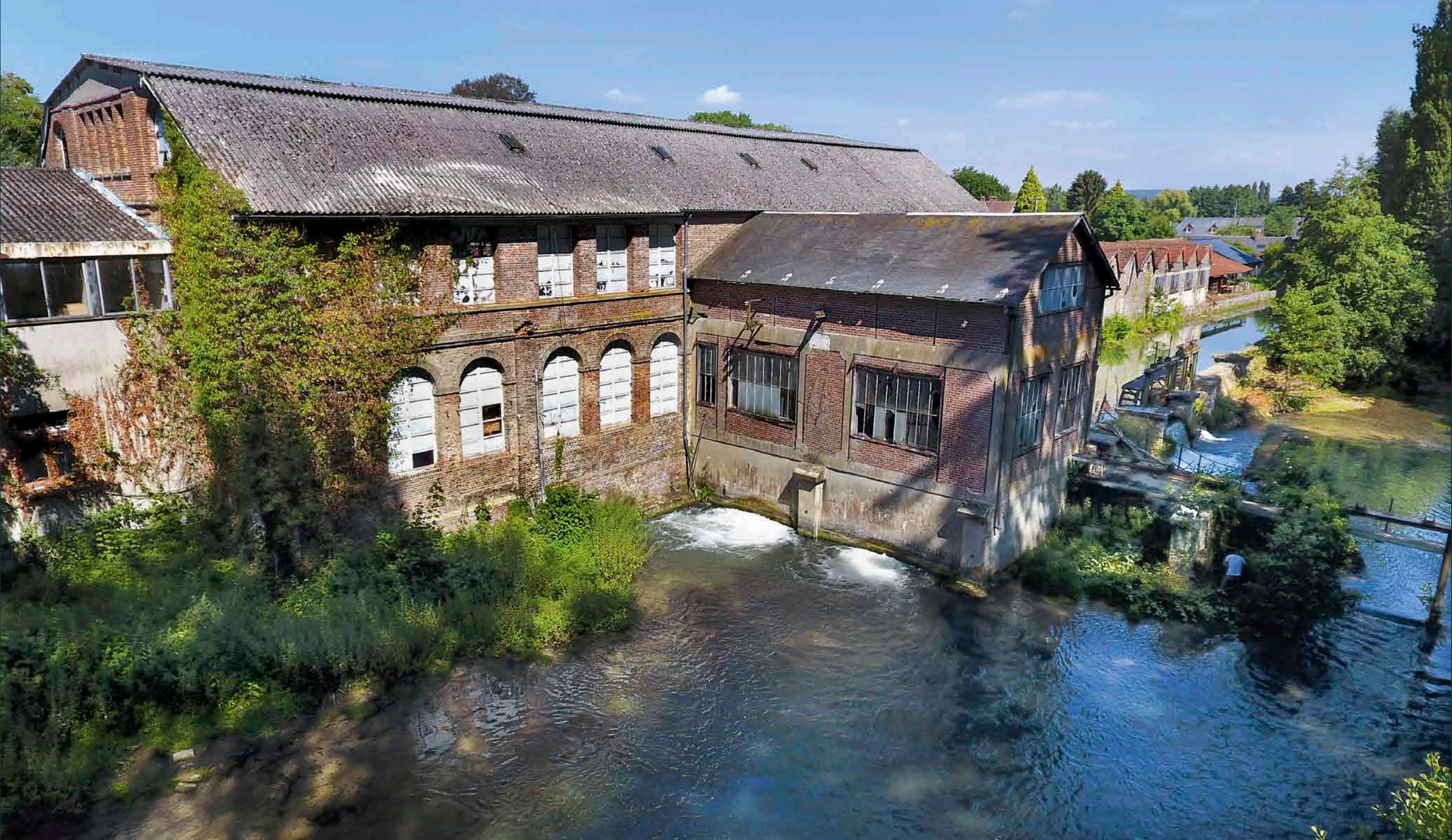
Vue aérienne de l'usine, photo Marius Biot. Le bâtiment à étages est celui de l'ancienne filature. Bien que le lieu soit dédié au travail, son architecture en brique avec des baies en arc plein cintre est particulièrement soignée. Le bâtiment construit sur le canal de dérivation est celui des turbines hydrauliques.
