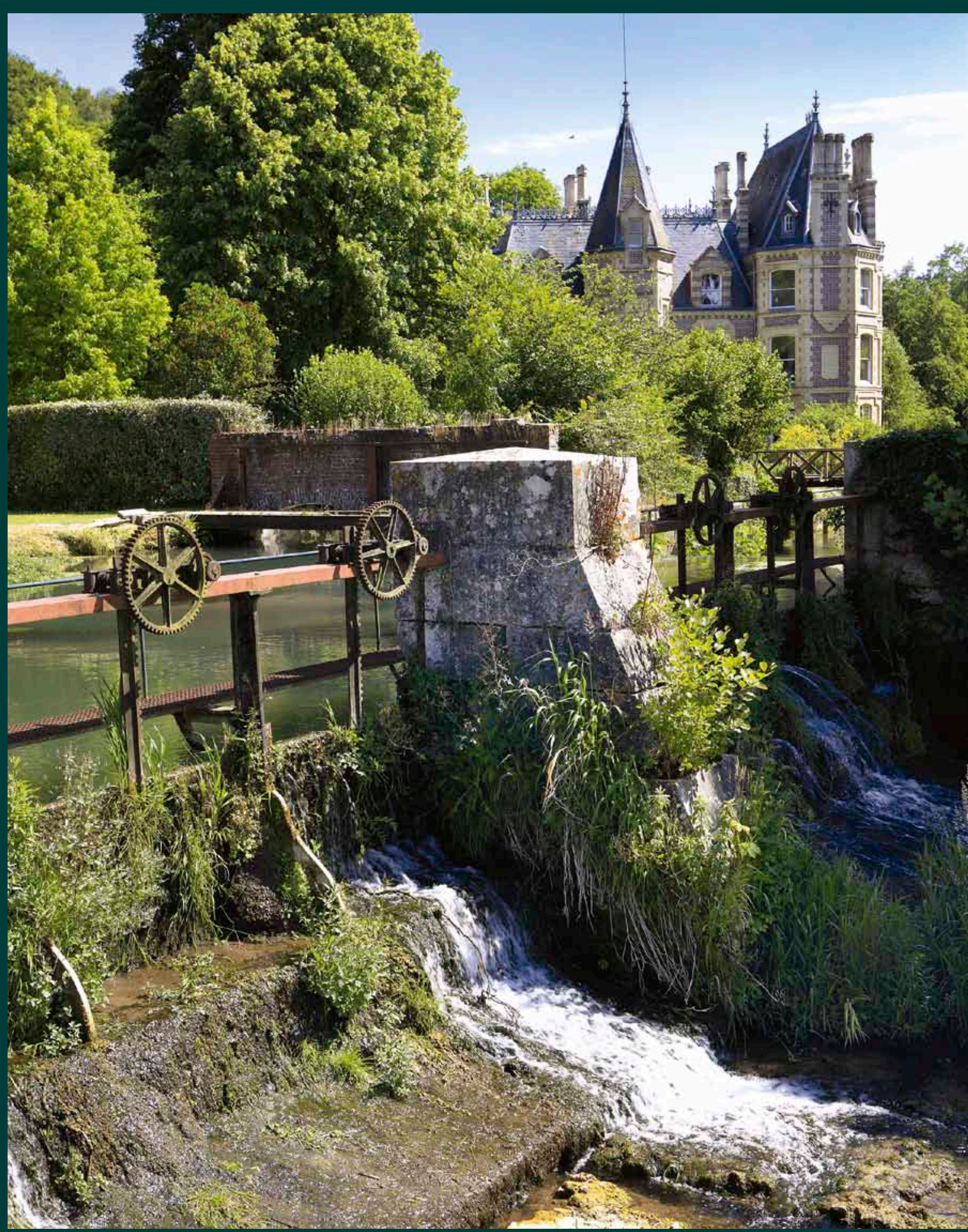
Perruel. Vannages et déversoir de la filature la Rouge (détruite).
