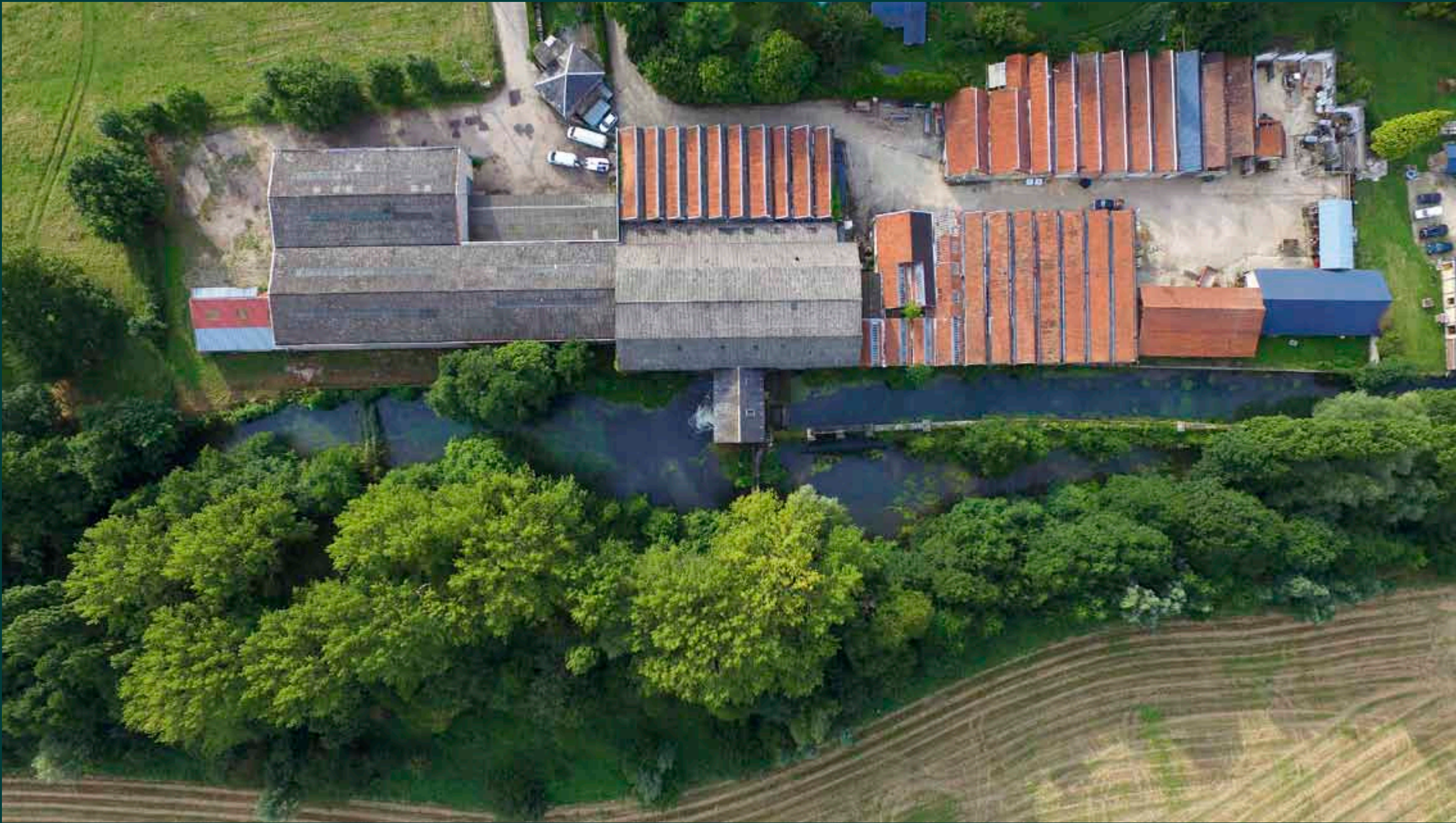
Vue aérienne du site, photo Marius Biot. Cette photographie permet de comprendre l'implantation du site sur le cours d'eau et d'identifier ses différentes phases de construction. Les bâtiments primitifs, identifiables par leur toiture grisée sont ceux de l'ancienne filature et de ses annexes (bâtiments du moteur hydraulique et de la machine à vapeur). Les ateliers construits en 1871, au moment où la filature est transformée en tissage, sont reconnaissables par leur toiture en tuile de couleur orange. L'usine a doublé de surface lors de ce changement d'activité.
