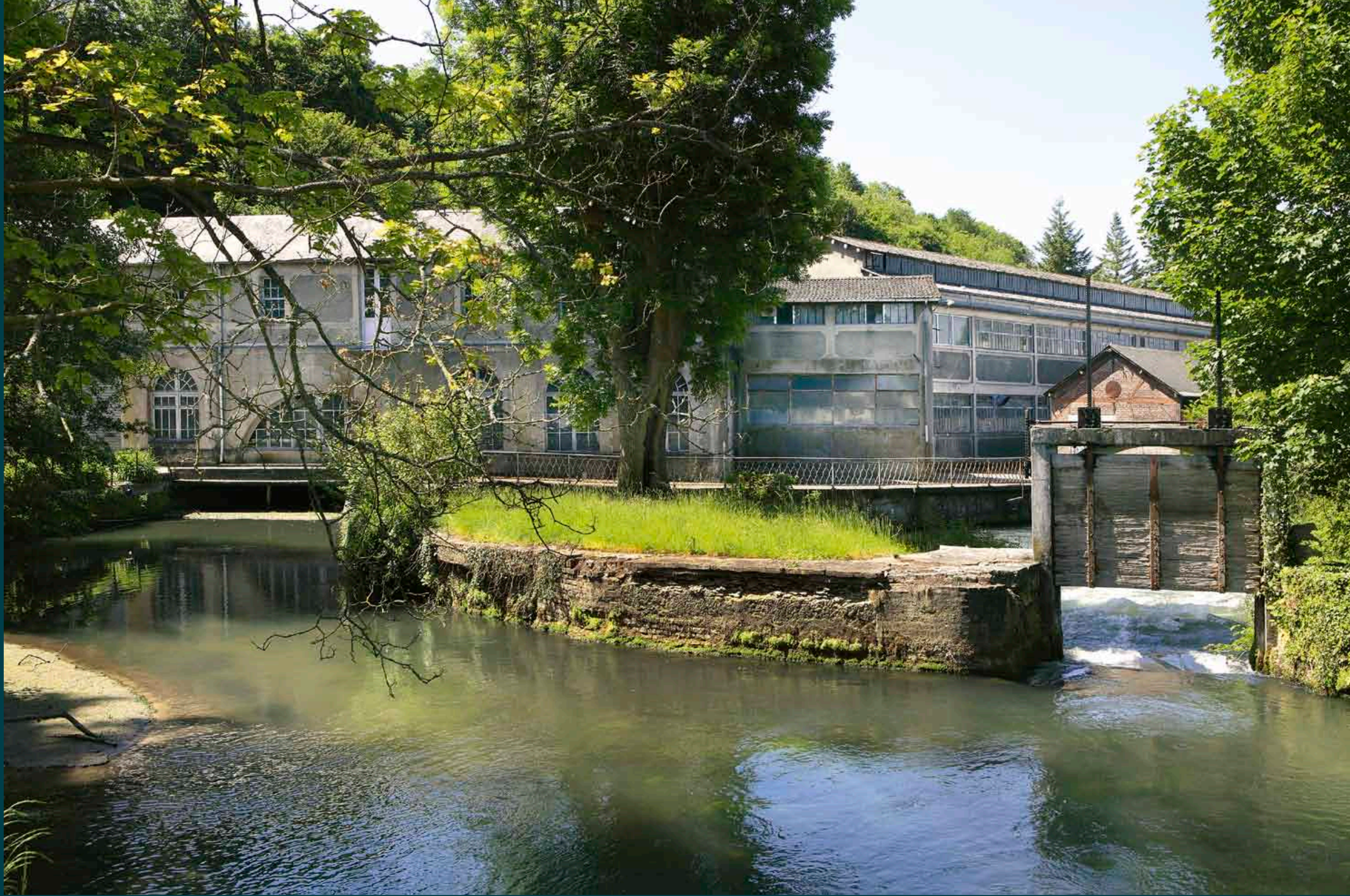
Pont-Saint-Pierre. Filature Mignot puis usine de selles de vélo Tron et Berthet. Ici les différents bras de l'Andelle servent de biefs pour l'usine. Y sont installés les ouvrages de régulation de l'eau tels que le vannage que l'on voit au premier plan.
