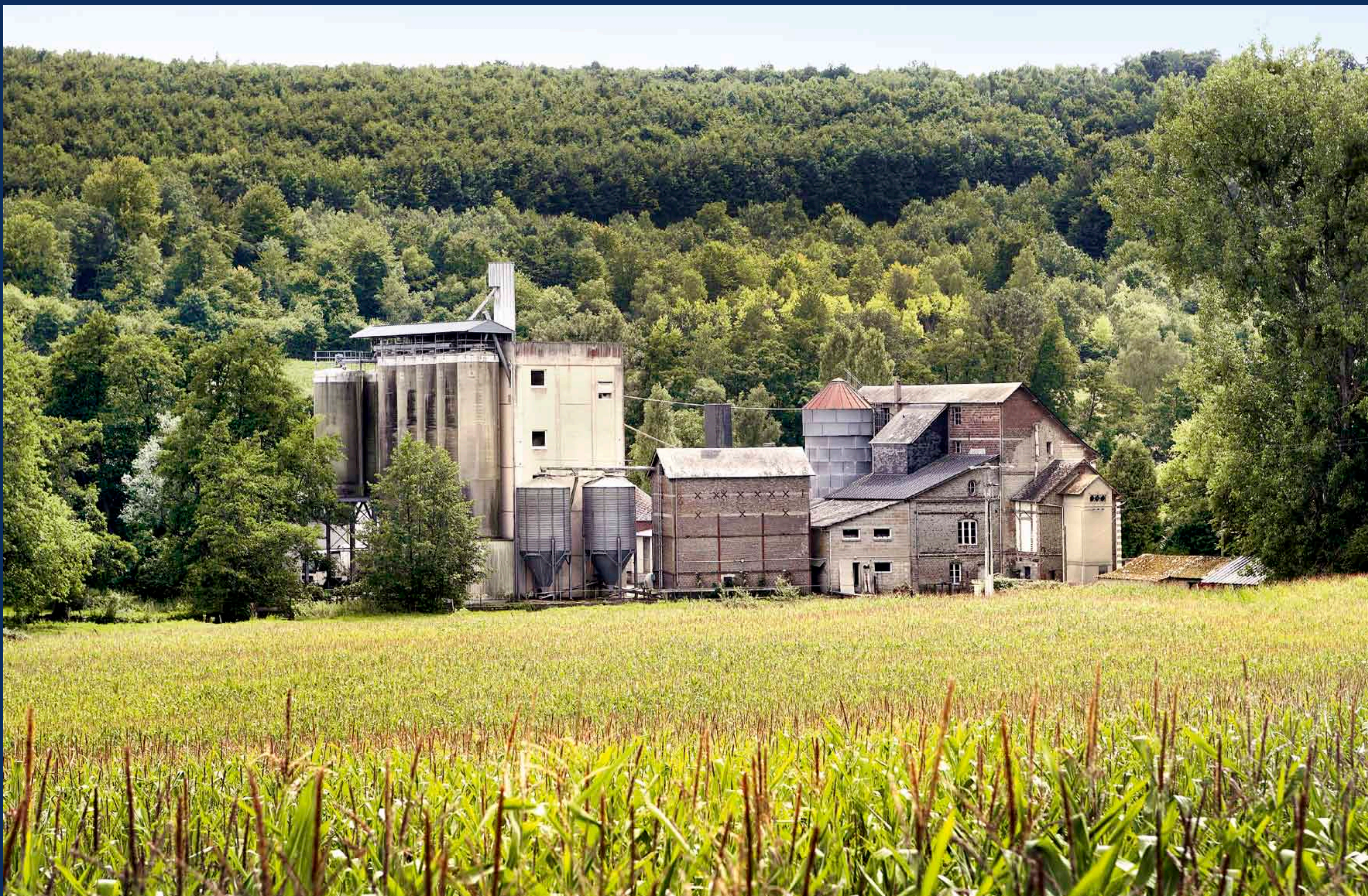
Vue d'ensemble du site avec, sur la gauche, la minoterie et les silos modernes en béton. Bien que la force hydraulique de la rivière ne soit plus utilisée, cette minoterie s'est maintenue sur son site d'origine grâce aux travaux de modernisation opérés tout au long du XX e siècle : extension des bâtiments de production, renouvellement du parc de machines, construction de nouveaux silos...
