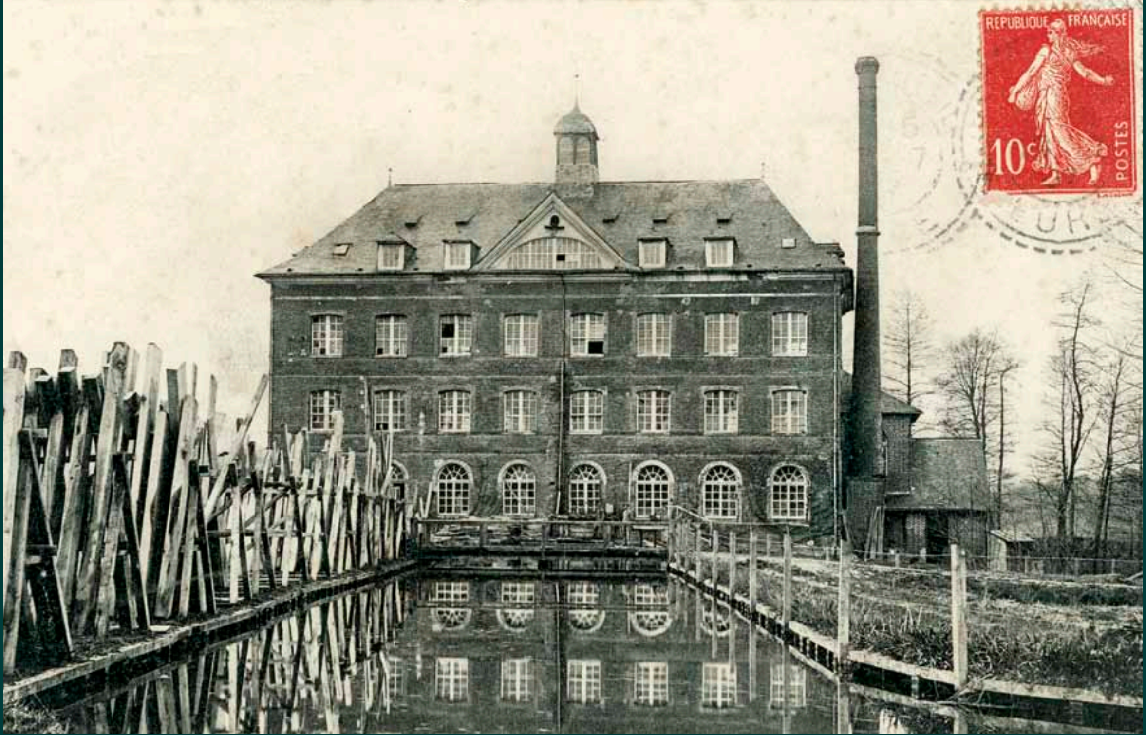
Ménesqueville. Filature Viel, également appelée la Grande filature. Construite en 1823, transformée en scierie en 1925, puis en usine de tissage du lin en 1948, elle est détruite en 1965 lorsque un danois, Anders Abildgaard rachète le site pour y installer une pisciculture.
