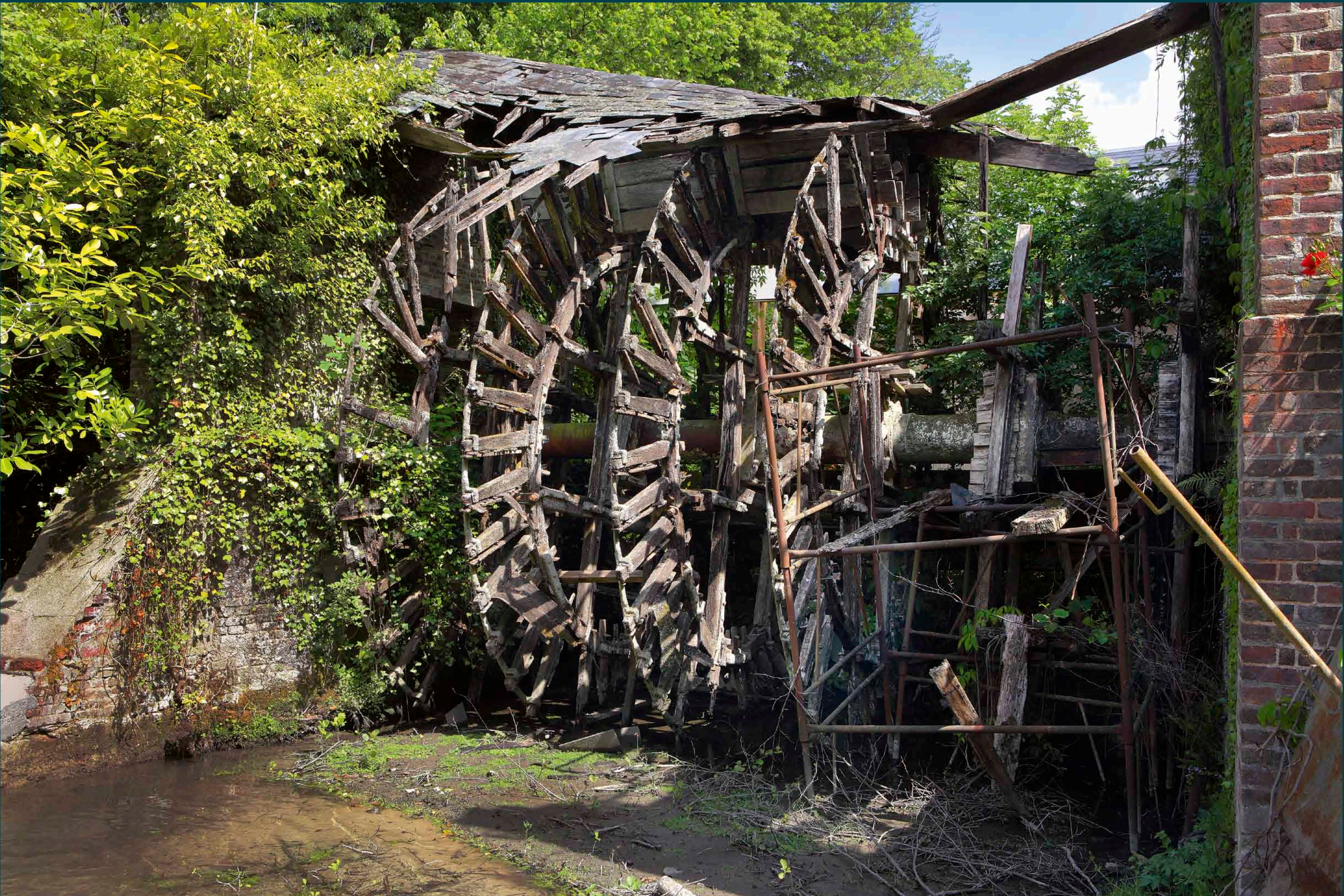
Douville-sur-Andelle. Moulin du Chapitre. Roue par-dessous en fonte à aubes planes en bois, de 4 m de diamètre et de 6 m de large, d’une puissance de 120 000 kWh. Cette roue hydraulique, aujourd’hui dans un état de vétusté avancé, était l’une des plus imposantes établies sur l’Andelle.
