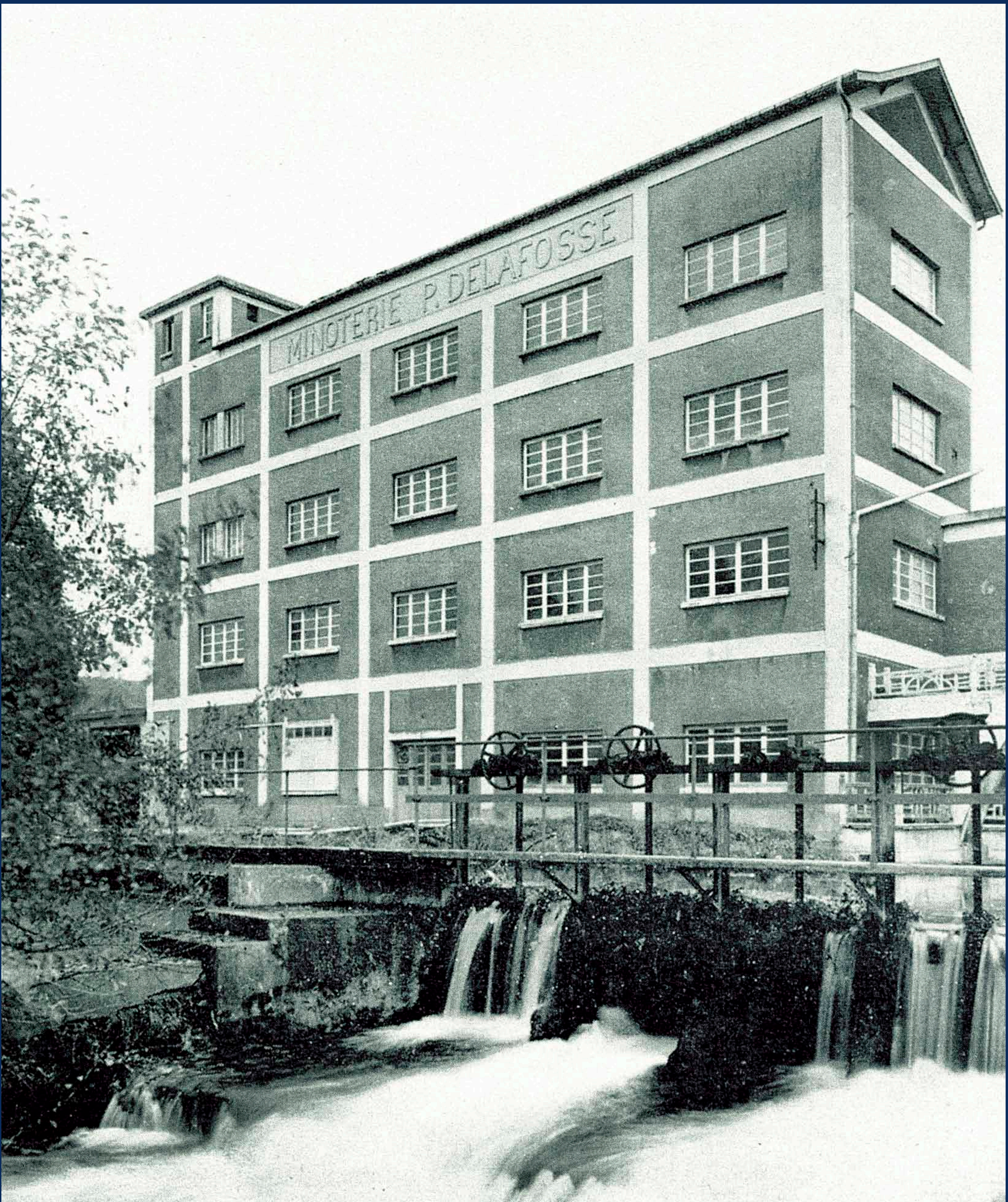
Romilly-sur-Andelle. Minoterie Delafosse, 1926. Cette minoterie tout en béton a fonctionné près de 50 ans puis a été reconstruite à la production d'aliments pour animaux. Elle est aujourd'hui désaffectée.
